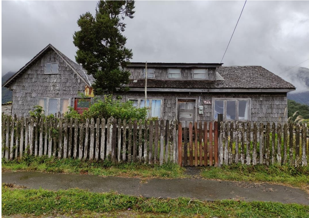
Figura 4. Vivienda de arquitectura chilota. Nótese la confección con tejuelas y la delimitación perimetral de madera
