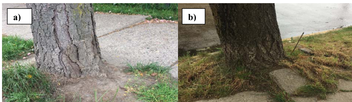
Figura 15. Indica falta de espacio de crecimiento para especies arbóreas inventariadas en sector estudiado. a) Árbol N°66, espacio insuficiente en veredón; b) Árbol N°72, levante de calzada y vereda por falta de espacio.
