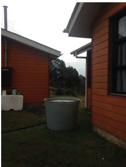
Fotografía 5: Contenedor que recoge agua lluvia desde una canaleta, isla Nayahué.
