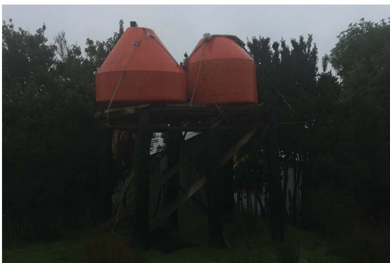
Fotografía 9: Torre de agua construida por los mismos habitantes. En vez de contenedores se utilizaron boyas que desechan las salmoneras. Isla Chuit.
