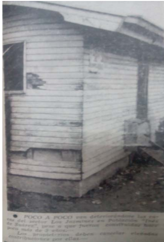
Figura 14: Muestra el deterioro de una vivienda en Población Los Jazmines a poco tiempo de su entrega a los propietarios, (Fuente: Correo de Valdivia 2/06/1969 p.9)
