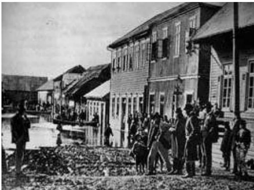
Fig. 13: Valdivianos junto a calle inundada en 1899 (Delgado, A., y Manríquez, A. 2012. Op. Cit, p. 54)
