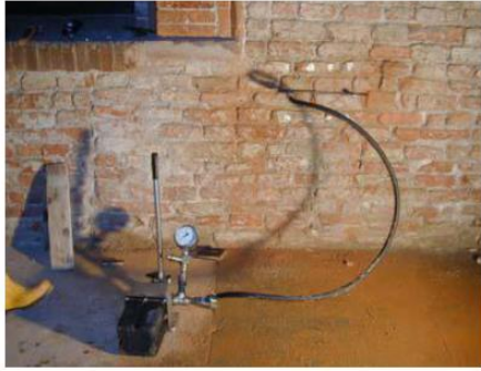
Fig. 4.51 Ensayo de gato plano sobre albañilería (Lombillo. 2010).
