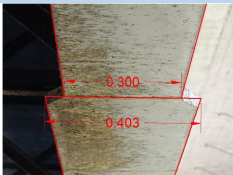
Fig. 4.5 Fotogrametría en vigas.
