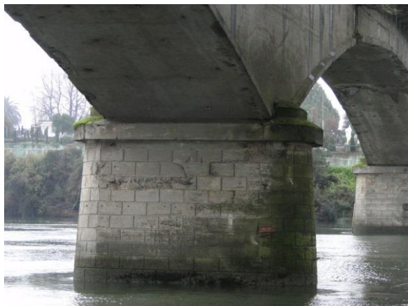
Fig. B.13 Unión viga y cepa
