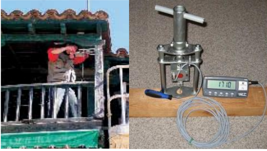
Fig. 4.49 Extracción de tornillos en obra (Basterra et al. 2009).
