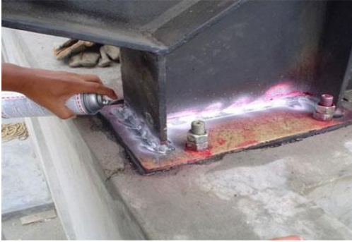
Fig. 4.8 Ensayos de soldadura mediante líquidos penetrantes (Geotecnia Consultores. S.f.).
