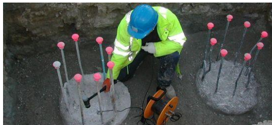
Fig. 4.20 Ensayo de impedancia mecánica en un pilote (Sanjuán. 2012).
