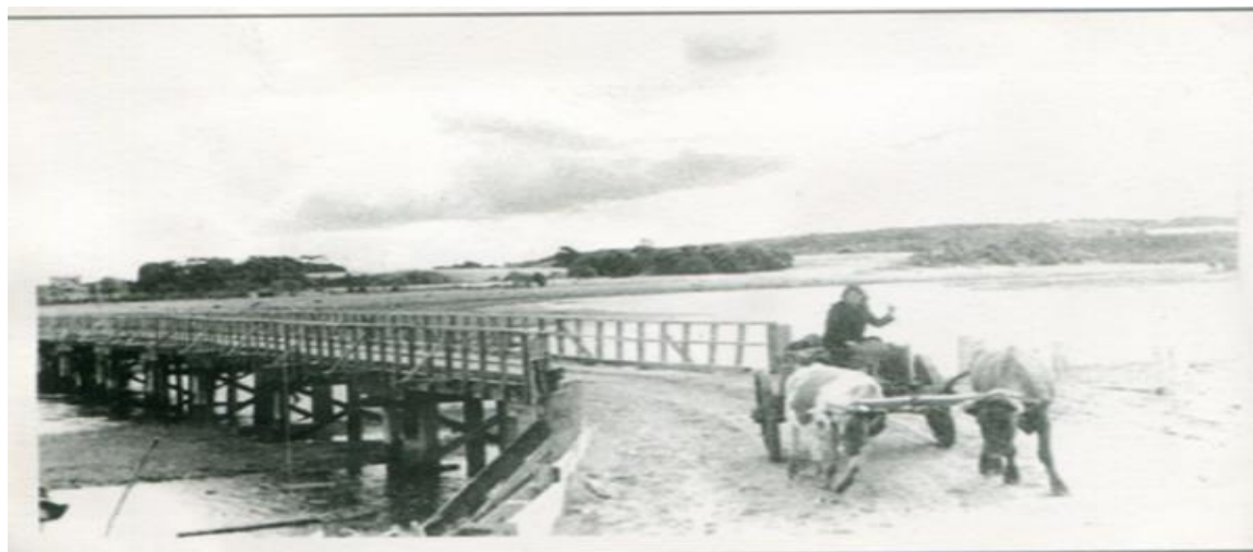
Figura 12. Fotografía del puente Pudeto de 1948, en donde se puede apreciar (lado derecho de la imagen) el sector de Caipulli y la dimensión y profundidad que alcanzaba para la época.
