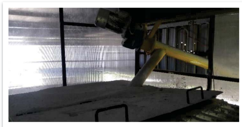
Figura N° 4.2: Tolva dosificadora de cal viva PTAS Puerto Varas-Llanquihue.
