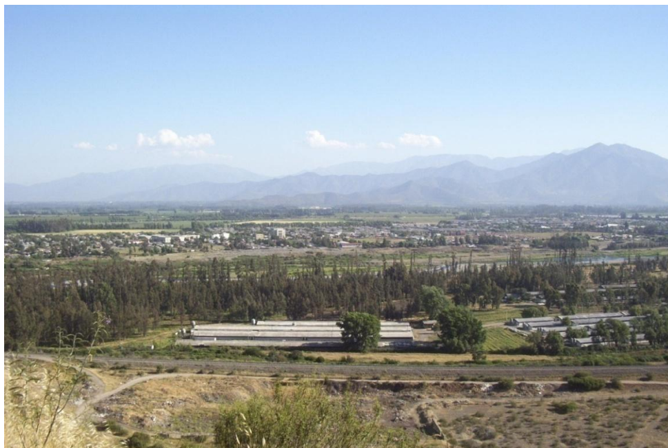
Figura16: En perspectiva se puede observar; instalaciones Agrícola El Monte S.A., río Mapocho, ciudad de Talagante, sector Tegalda [Fuente: Elaboración propia ]
