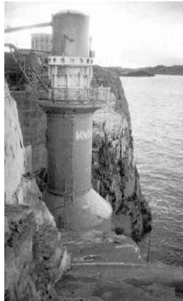
**Figura 4. Planta Toftestallen, Noruega (1985), dispositivo de orilla con una potencia instalada de 600 kW.**
