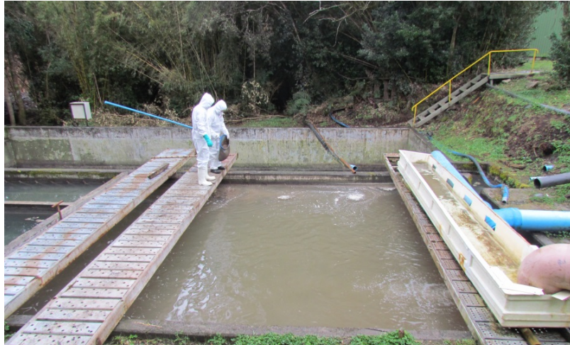
Figura N° 19: Estanque de decantación en piscicultura de flujo abierto
