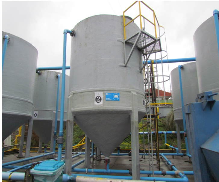
Figura N° 46: Extracción del lodo residual crudo en piscicultura de recirculación.
