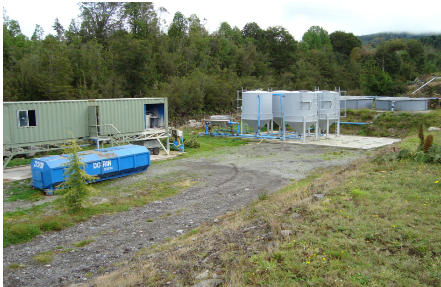
Figura N° 13: Área para el manejo y tratamiento de lodos residuales en piscicultura de recirculación.
