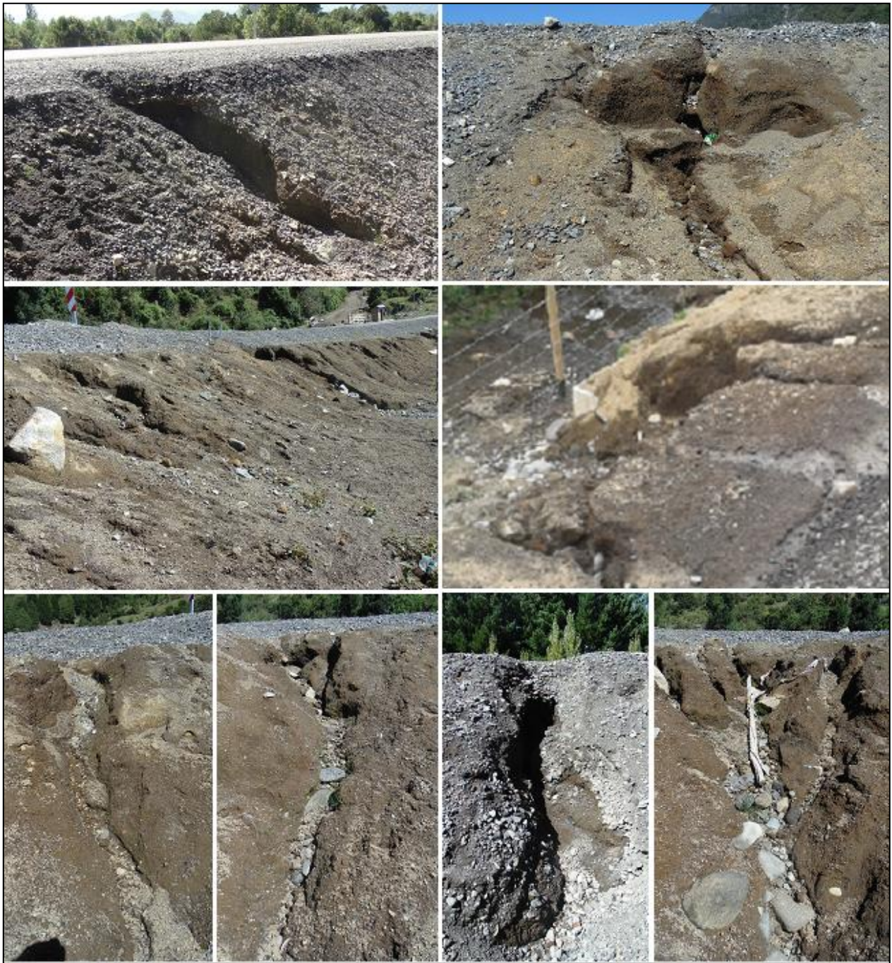
Fig. 1.1 - Erosión de los terraplenes en estudio en distintos puntos de la carretera
