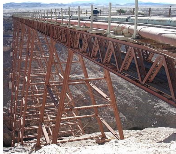
Fig. 2.25: Puente Cochi, Calama, Chile ( http://picasaweb.google.com ).
