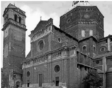
Fig. 2.6: Torre de Pavia antes de que sufriera daños (Garavaglia et al., 2006).
