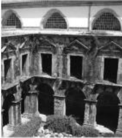
Fig. 2.11: Claustro del Monasterio de Salzedas antes de los trabajos actuales (Lourenço et al., 2008).
