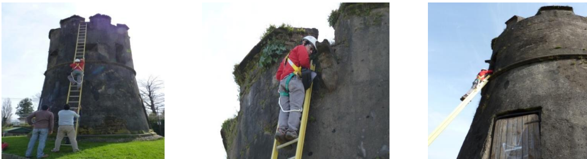
Fig. 5.3: Campaña de mediciones en terreno. De izquierda a derecha: 1) Medición geométrica de la estructura. 2) Instalación del sismómetro en una de las gárgolas del torreón. 3) Medición geométrica e instalación del sismómetro en una de las ventanas del torreón.
