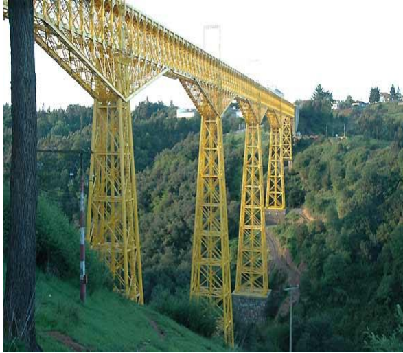
Fig. 2.24: Viaducto del Malleco, Collipulli, Chile ( www.welcomechile.com ).
