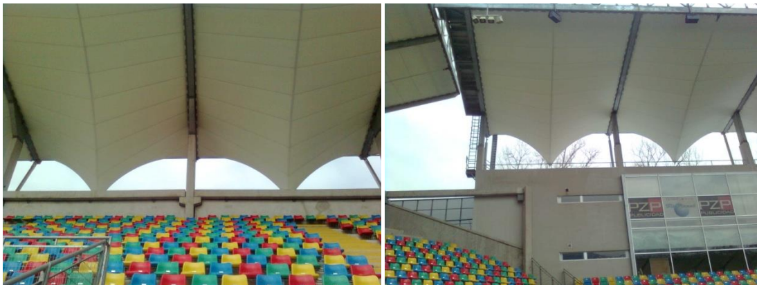
Figura B.7 – Cubierta del estadio.
