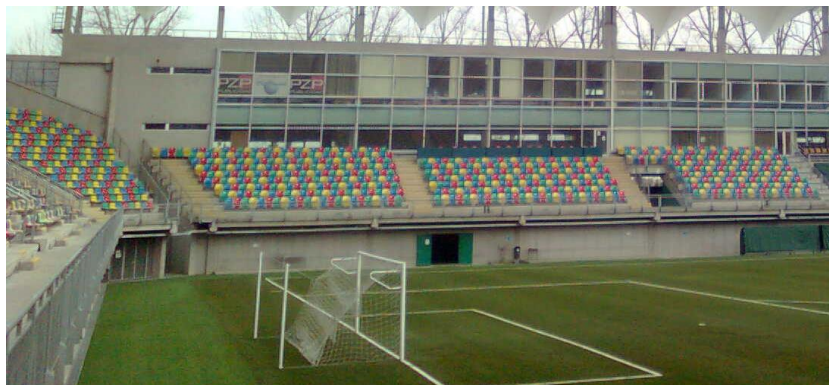
Figura B.2 - Vista del edificio administrativo y de servicios, al costado poniente del estadio.
