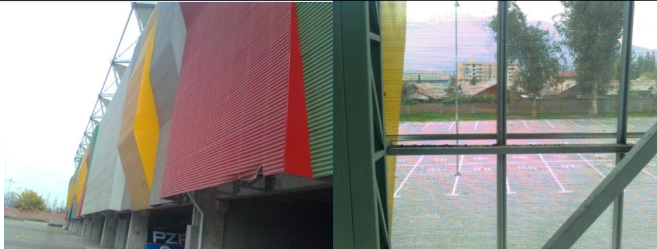
Figura B.4 - Vista de la fachada ventilada. A la izquierda se observa una vista desde el exterior del estadio y a la derecha una vista desde el interior hacia el estacionamiento.
