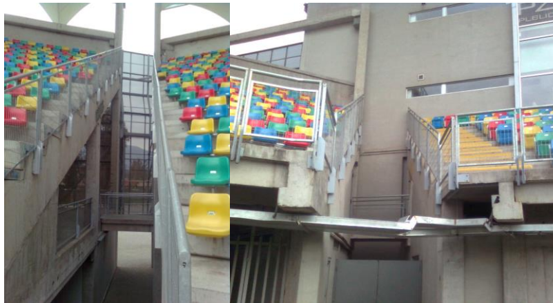
Figura B.3 – Separación entre distintos sector de graderías. En la figura se observa la esquina nor-oriente (izquierda) y la esquina sur-poniente (derecha).
