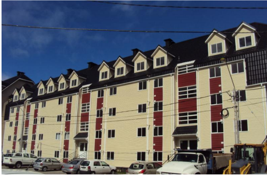
Figura 7: Edificios 12 – 11 – 10 tipo B Condominio Parque del Valle.
