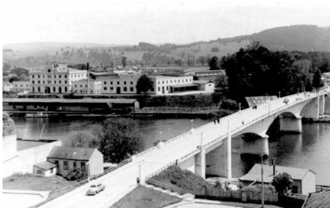
Figura 4. 1: Puente Pedro de Valdivia desde el Hotel del mismo nombre, poco antes del terremoto de 1960. Fuente: Wikilosrios, 2010.
