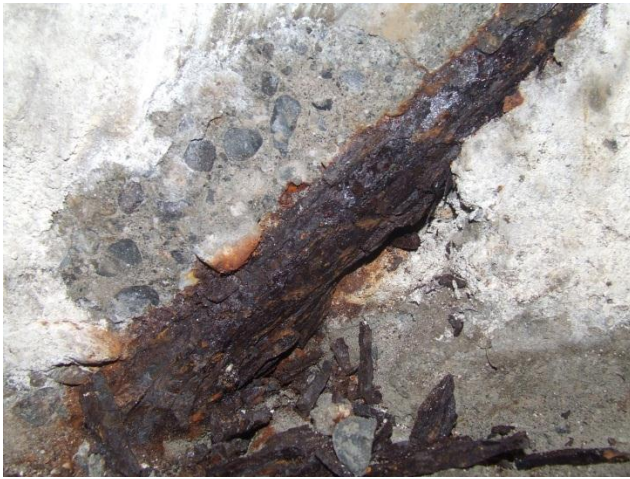
Figura 4. 19: Armadura corroída.
