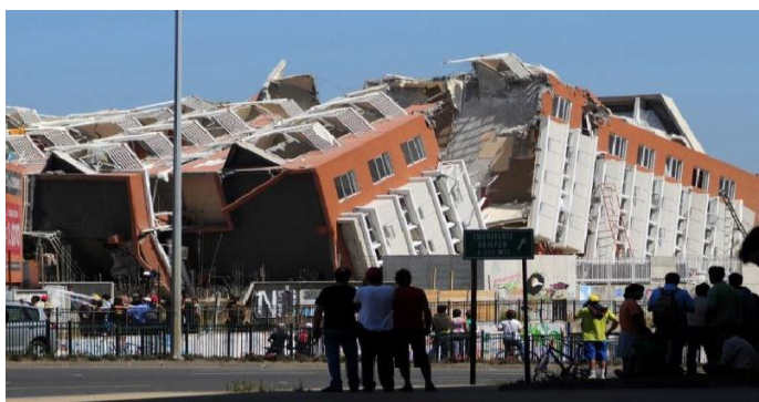
Figura 1. 13: Edificio colapsado en la ciudad de Concepción.
