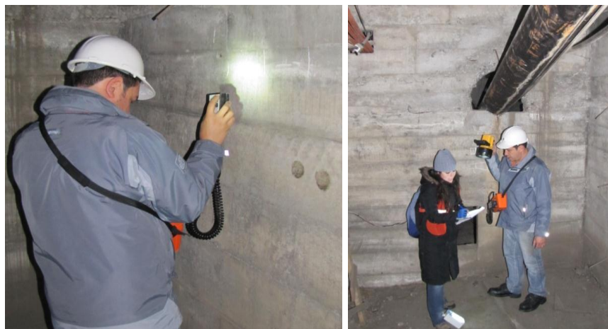
Figura 5. 11: Medición con el equipo BARTRACKER de CONTROLS en una de las vigas cajón del puente Pedro de Valdivia.
