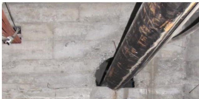
Figura 4. 22: Perforación diafragma.
