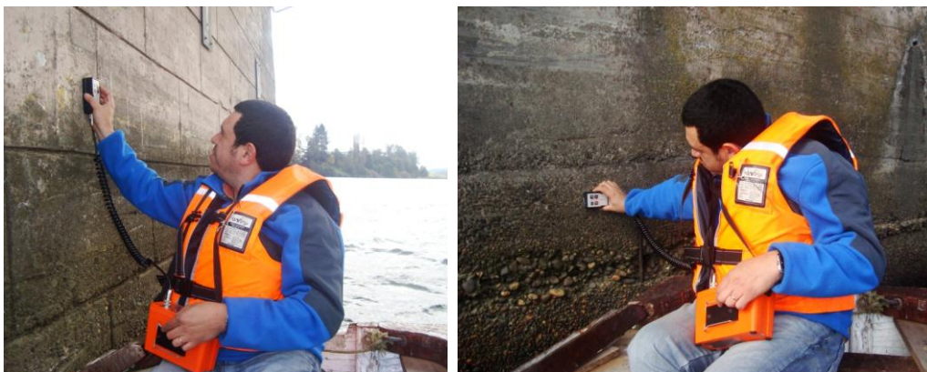
Figura 5.10: Campaña de auscultación. A la izquierda: Pilar central. A la derecha: Pilar Extremo.
