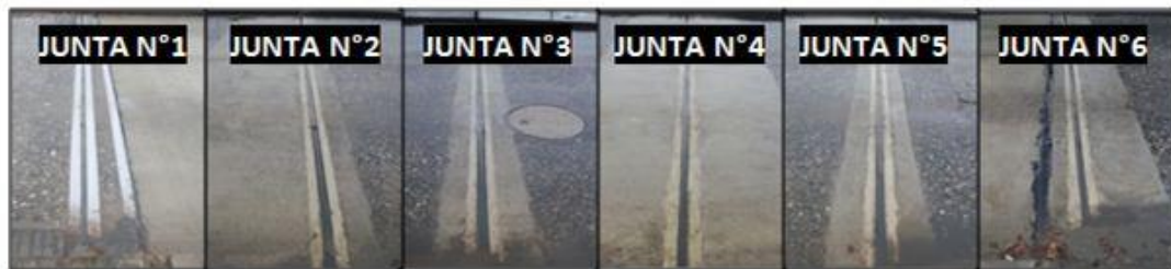
Figura 4. 16: Juntas de dilatacion Actual, desde el centro hacia la Isla Teja.
