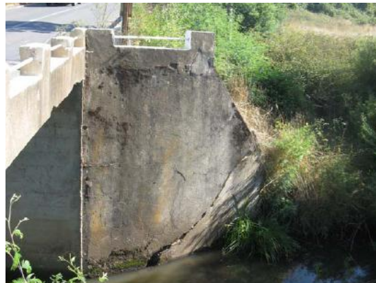
Figura 2. 17: Puente Punchema, daño en ala del estribo. Fuente: Ministerio de obras públicas, 2010.
