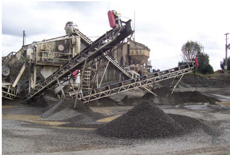
Figura N°6: Planta Chancadora, Fuente: Áridos Erich Guerrero, oct. 2010 Puerto Montt.
