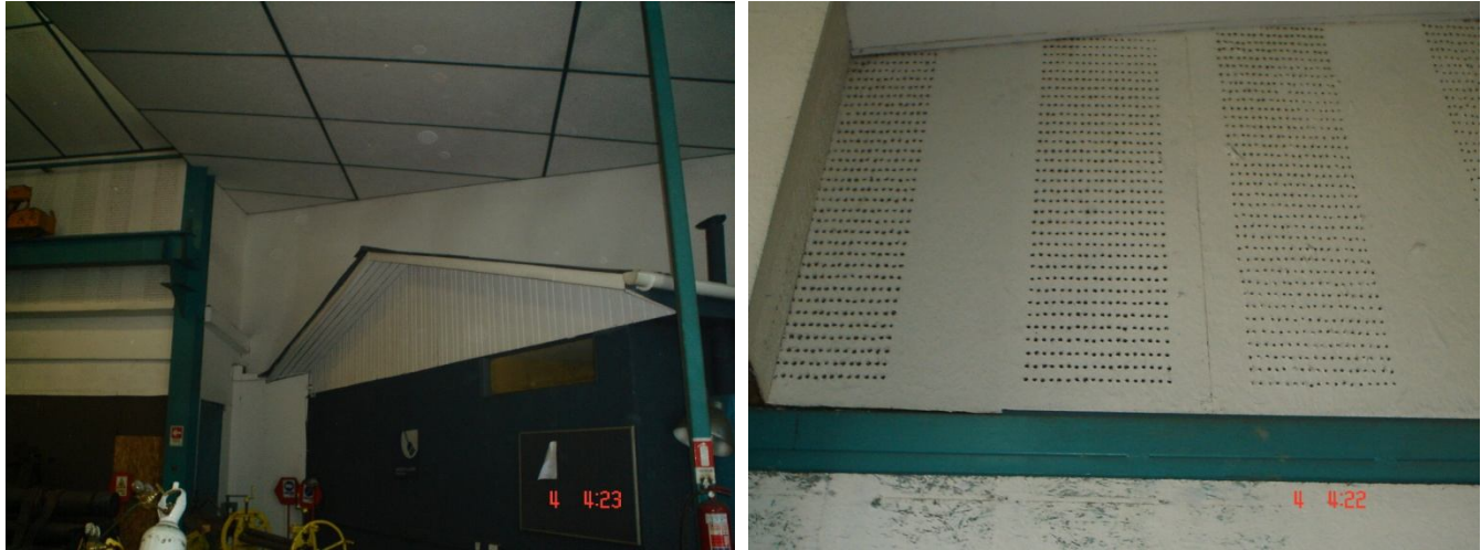
Ilustración 5.8. Revestimiento panel doble OSB implementado en el taller de calderería y Centrimecanizado.
