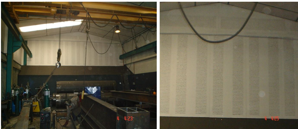
Ilustración 5.7. Revestimiento panel doble OSB implementado en el taller de caldereria.
