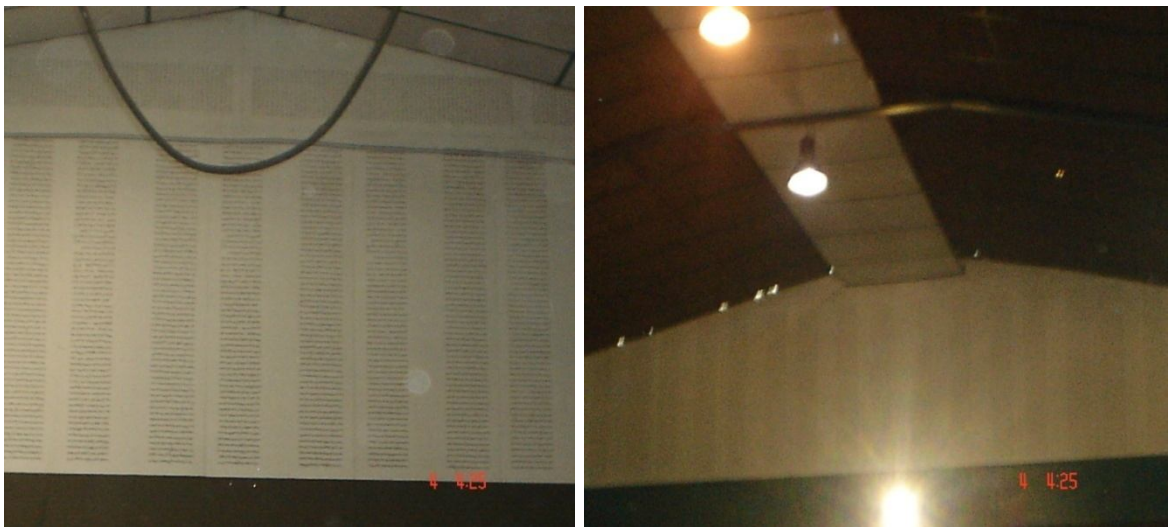
Ilustración 5.5. Revestimiento panel doble OSB implementado en el galpón.
