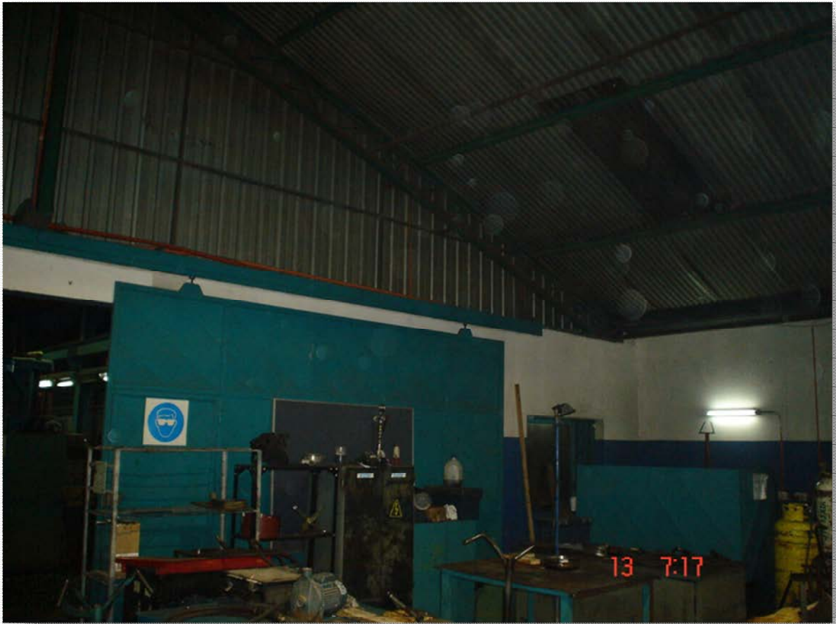
Ilustracion 5.4. Taller de calderería interior.
