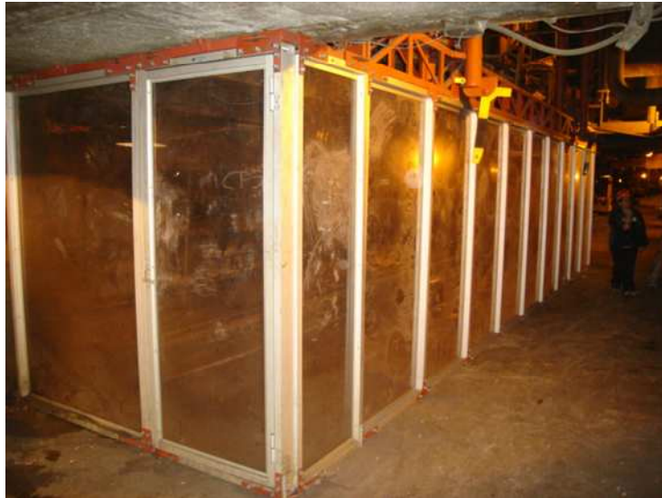
Figura 8.6. “Barrera Acústica CPS2 a Nivel de Piso”
