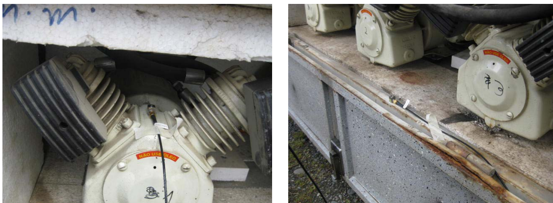
Figura 5.12: Acelerómetro instalado sobre un compresor de aire y sobre la estructura del gabinete de instalación de los compresores.
