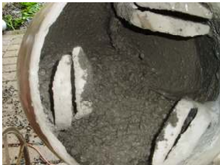
Figura 4.1.(b): Betonera de Baja Revolución en Confección de Mezcla (Fuente: Elaboración Propia)
