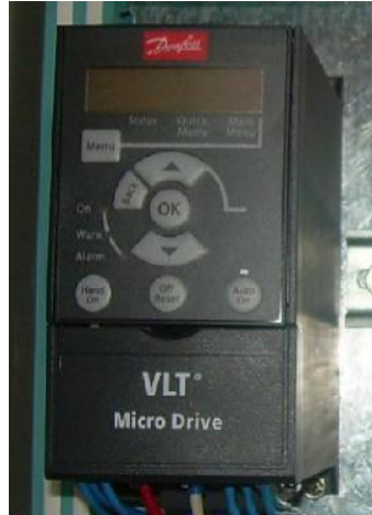
FIGURA N° 9: Variador de frecuencia
