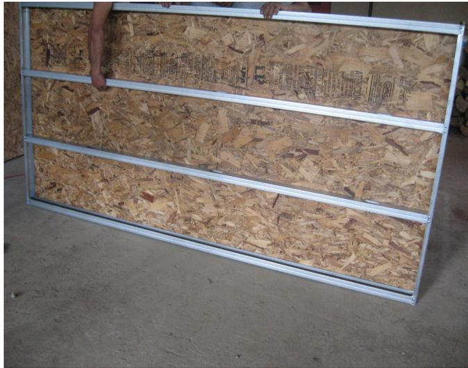
Figura 2.6 Estructura del panel en que los montantes están separados a 40 cm., y se ve revestido por una cara con tablero OSB
