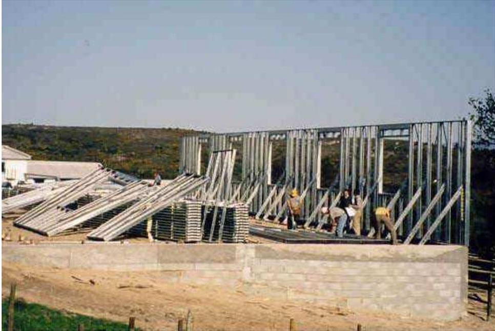
Figura 1.1 Estructuración en base a perfiles de acero galvanizado
