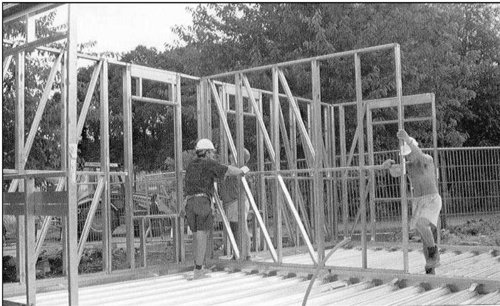
Figura 2.4 Levantamiento de Soleras y Montantes
