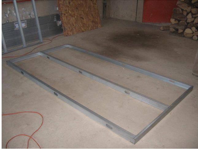
Figura 2.5 Estructura del panel en que los montantes están separados a 60 cm
