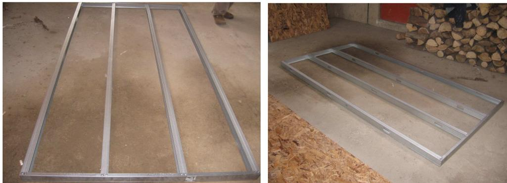
Figura 2.7 Estructura del panel, en que los montantes están separados a 40 cm
