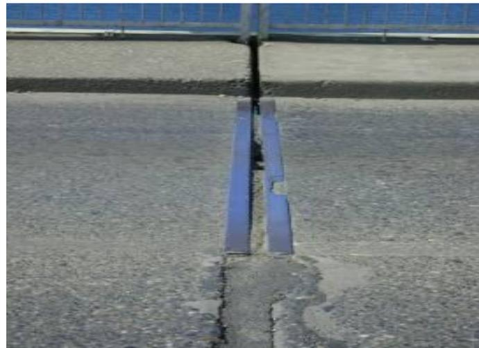
El daño existente se debe al término de vida útil de los elementos que componen una junta de dilatación tradicional, cuyo aspecto se muestra en figura 1.
