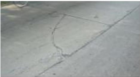
**Posibles Causas:** Son causadas por la repetición de cargas pesadas (fatiga del hormigón) combinadas con la acción drenante, que debilita y erosiona el apoyo de la fundación, así como también por una deficiente
