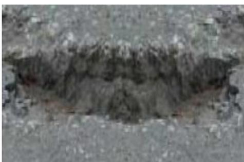
**Posibles causas:** Los baches se producen por conjunción de varias causas: fundaciones y capas inferiores inestables; espesores del pavimento estructuralmente insuficientes; defectos constructivos; retención de agua en zonas hundidas y/o fisuradas. La
