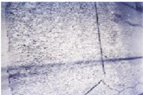
**Posibles causas:** Son causadas por el efecto abrasivo del tránsito sobre hormigones de pobre calidad, ya sea por el empleo de dosificaciones inadecuadas (bajo contenido de cemento, exceso de agua, agregados de inapropiada granulometría), o bien por deficiencias
