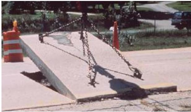
A veces las juntas del hormigón están tan deterioradas que hacen insegura su remoción por levantamiento. En estos casos es necesario romper el hormigón deteriorado en pequeños fragmentos que pueden ser retirados por retroexcavadoras y herramientas manuales.
