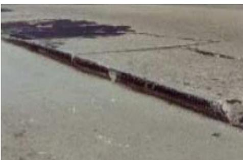
**Posibles causas:** Es el resultado en parte del ascenso a través de la junta o grieta del material suelto proveniente de la capa inferior de la losa (en sentido de la circulación del tránsito) como también por depresión del extremo de la losa posterior, al disminuir el soporte de la fundación. Son manifestaciones del fenómeno de bombeo, cambios de volumen que
