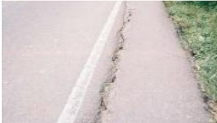
**Posibles Causas:** Generalmente esta relacionada con el movimiento de la berma debido a problemas de inestabilidad de los taludes aledaños o con la ausencia de liga entre la calzada y la berma cuando se construyen por separado.
