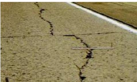
**Posibles causas:** Son causadas por la repetición de cargas pesadas, pérdida de soporte de la fundación, gradientes de tensiones originados por cambios de temperatura y humedad, o por las deficiencias en la
