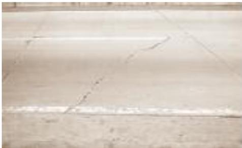
**Posibles Causas:** Son causadas por una combinación de los siguientes factores: excesivas repeticiones de cargas pesadas (fatiga), deficiente apoyo de las losas, asentamientos de la fundación, excesiva relación longitud / ancho de la losa o deficiencias en la
