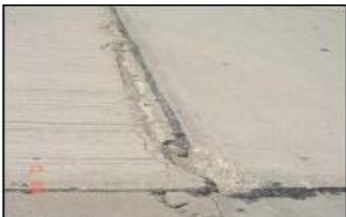
**Posibles causas:** Los despostillamientos se producen como consecuencia de diversos factores que pueden actuar aislada o combinadamente; excesivas tensiones en las juntas ocasionadas por las cargas del tránsito y/o por infiltración de materiales incompresibles; debilidad
