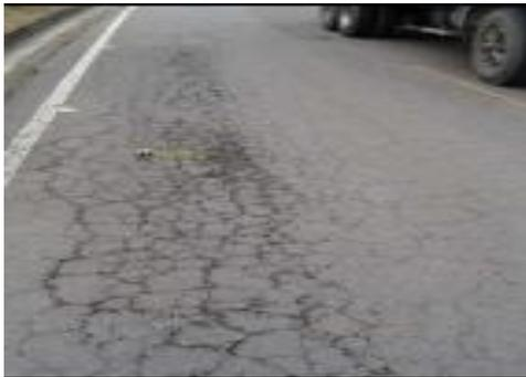
**Posibles Causas:** La causa más frecuente es la falla por fatiga de la estructura o de la carpeta asfáltica principalmente debido a:
