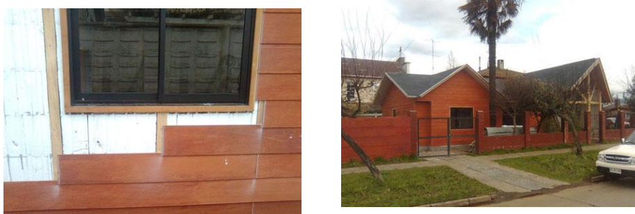
Fig. 12. Vivienda con ladrillos EPS en Loncoche.
