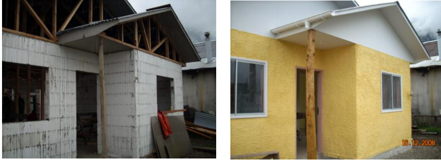
Fig. 10. Vivienda con ladrillos EPS en Aysén.
