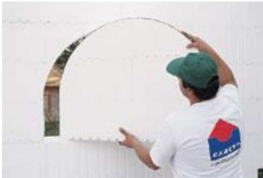
Fig. 19. Aberturas para puertas y ventanas en ladrillos EPS.
