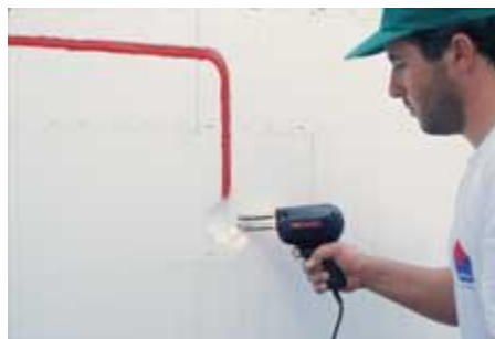
Fig. 22. Aberturas de diámetro pequeño para muros con ladrillos EPS.
