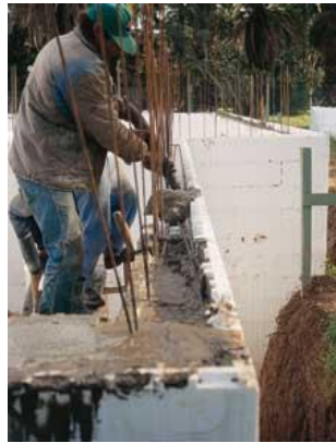
Fig. 20. Hormigonado de muros con ladrillos EPS.
