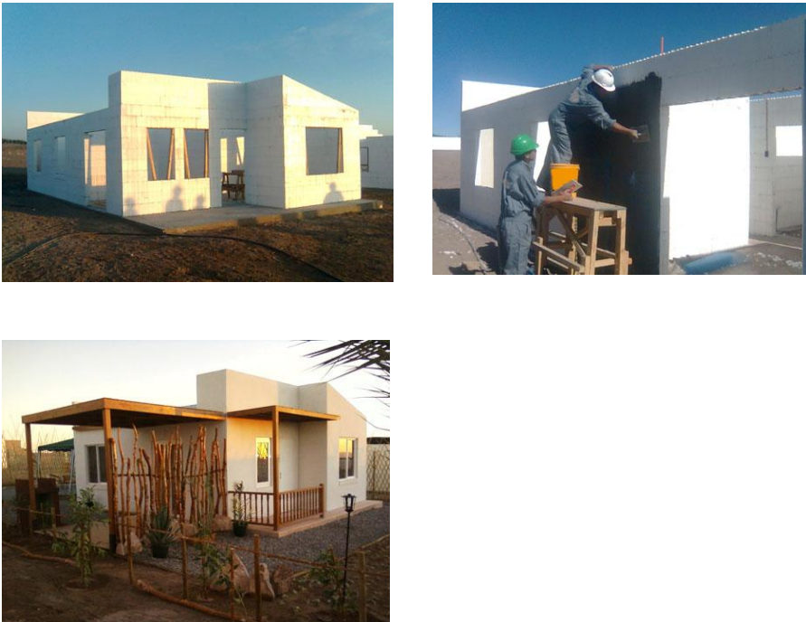
Fig. 11. Vivienda con ladrillos EPS en Pica.
