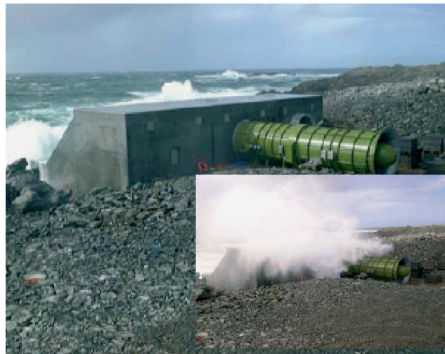
Figura 1.d Sistema LIMPET desarrollado en Irlanda. Recibe el impacto del oleaje y comprime aire de forma cíclica para accionamiento de la turbina 10
