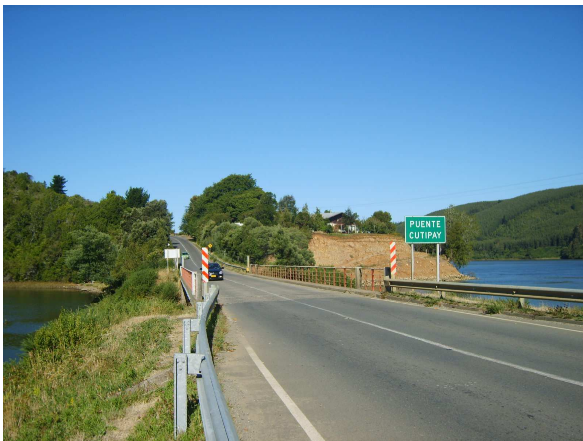
Fig. 5.1 Puente Cutipay – Valdivia- Niebla
