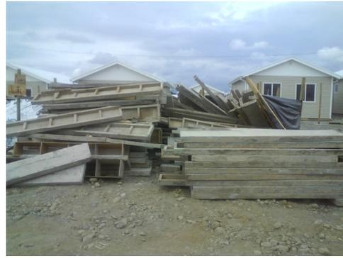
**Fig. 6.6:** Acopio de moldajes dañados y
