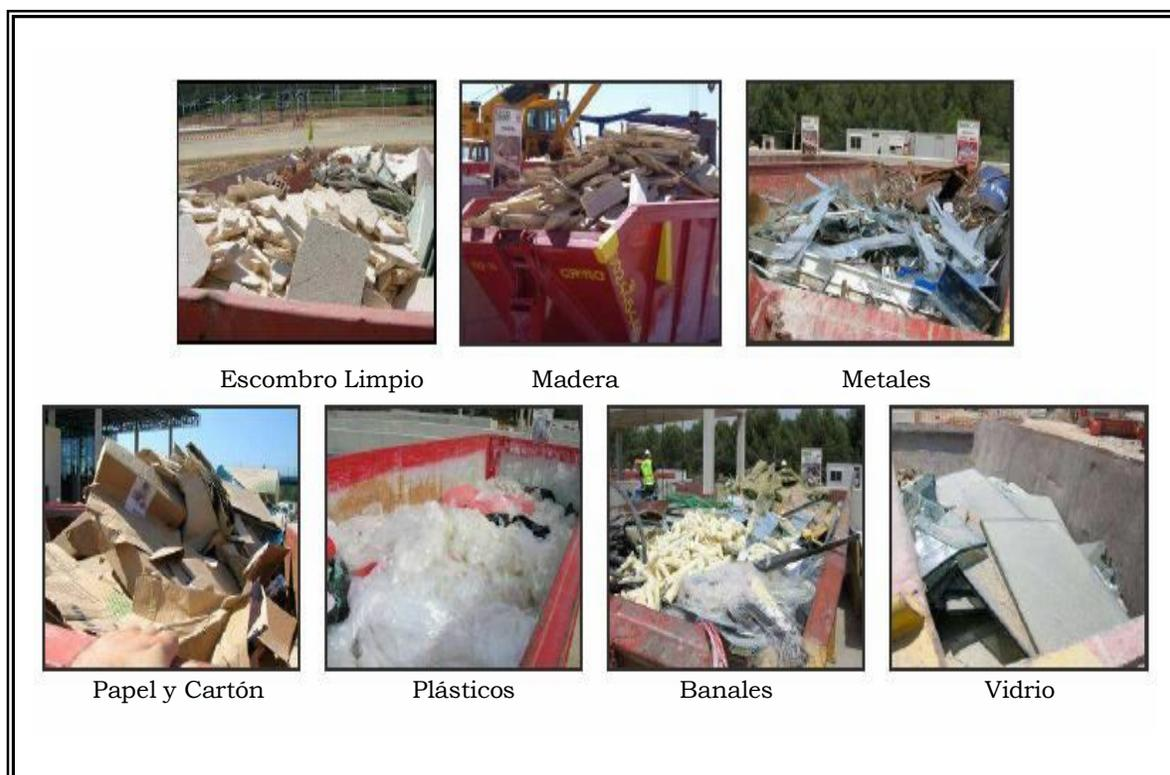
**Figura 4.2:** Fracciones de residuos de construcción separadas en obra.
