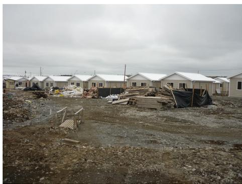
**Fig. 6.1:** Punto de acopio segregado de residuos.
