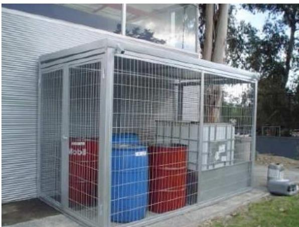
**Fig. 5.12:** Acopio residuos peligrosos.
