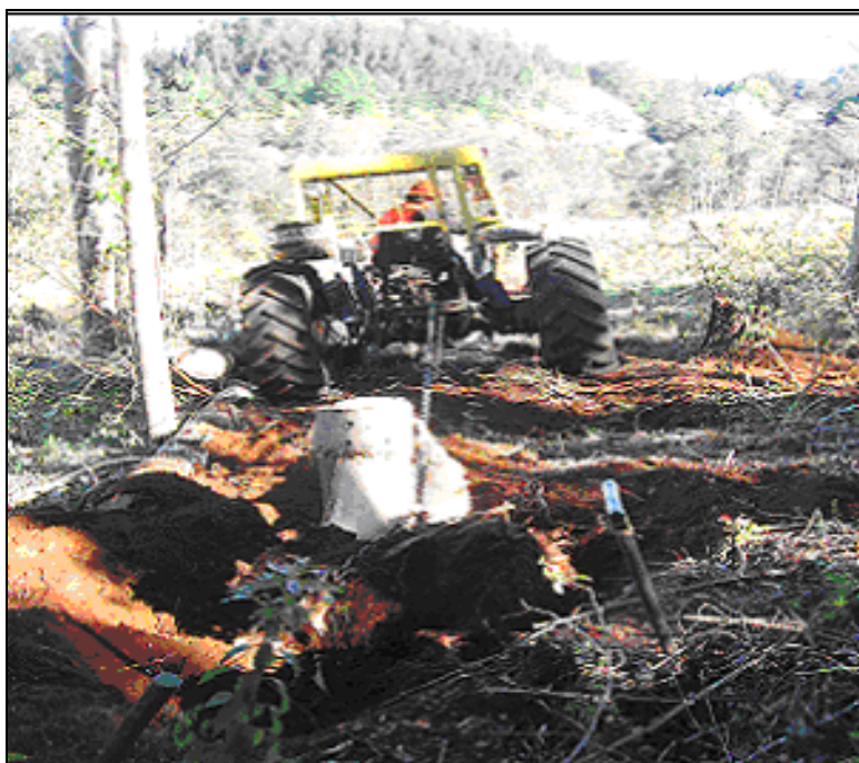
Figura 10. Remoción de raíz con tractor.
