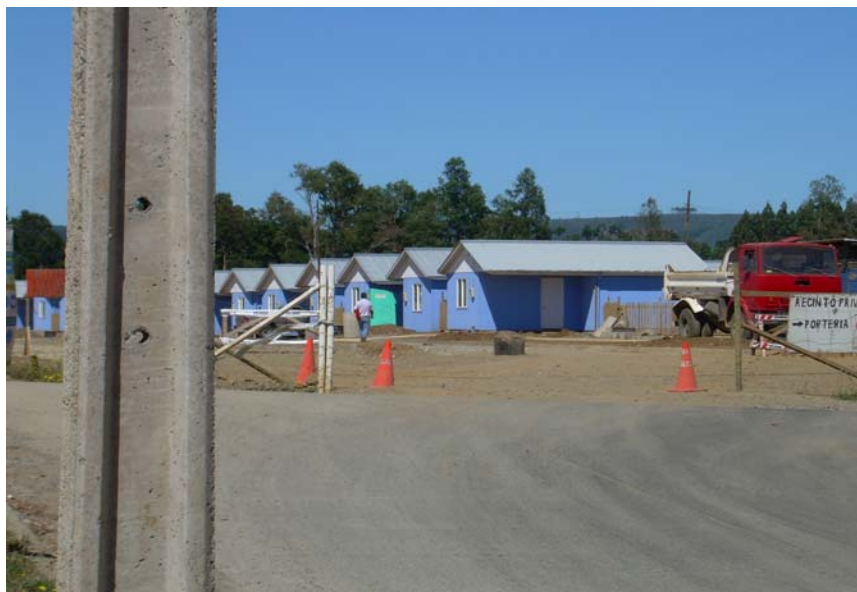
Construcción de viviendas sociales pertenecientes a Comité “Nuestros Sueños I”, conformados por allegados y ubicado al frente de Villa La Estancia
