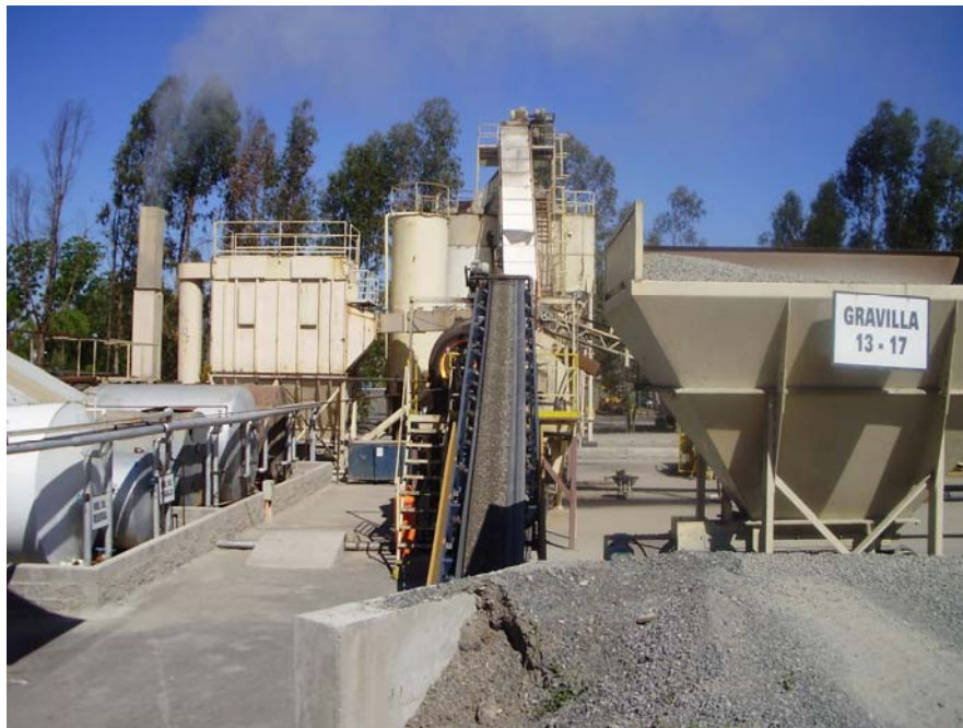
Fotografía 4.10: Visualización general de planta de asfalto.
