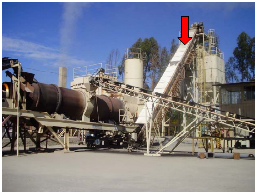
Fotografía 1.7: Ilustración de paleta de arrastre de la mezcla asfáltica.
