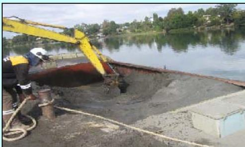
**Fig. 8.5:** Al llegar el falucho al muelle, el material es descargado con excavadoras y puesto en un buzón de carga (Fuente: Elaboración Propia)
