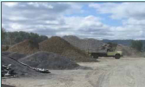
**Fig. 8.13:** El material es acopiado por separado, evitando mezclas indeseadas (Fuente: Elaboración Propia)
