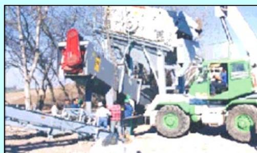
Fig. 3.6: Construcción: instalación de las cintas transportadoras. (Fuente: MOP, MINVU, CChC, 2001)
