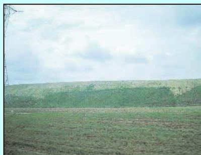
Fig. 7.29: Escombrera de estériles inertes revegetada con hidrosiembra, usada como pantalla visual y acústica (Fuente: Asociación Nacional de Empresarios Fabricantes de Áridos, 2005)
