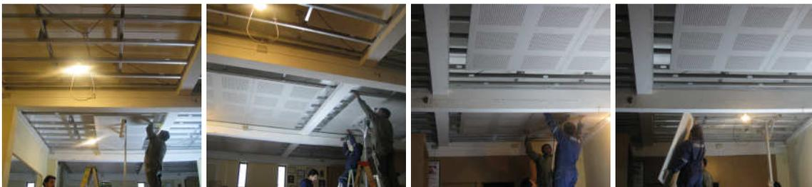
**Figura 31:** Instalación placas perforadas.
