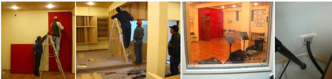
**Figura 39:** Instalación de los absorbentes, los difusores, el visor acústico y paso de cables a la sala de control.
