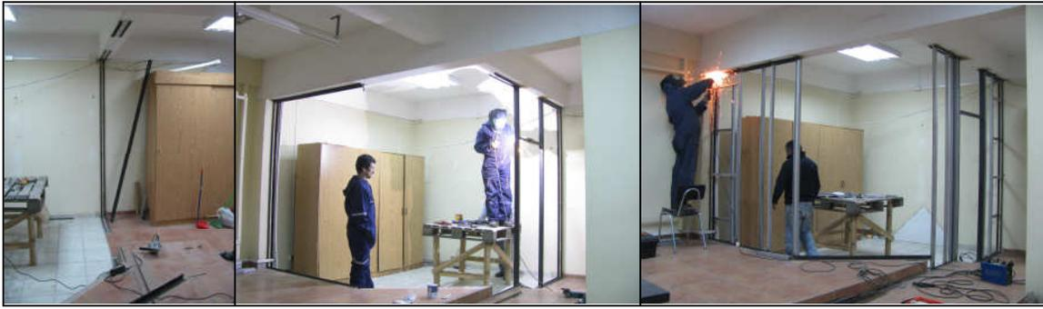
**Figura 28:** Armado de nueva estructura del muro de la sala de control.
