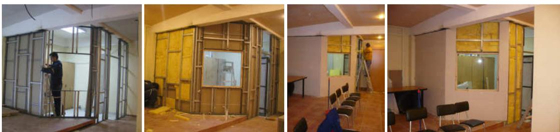
**Figura 35:** *Revestimiento sala de control.*
