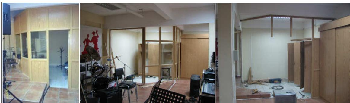
**Figura 27:** Desarmado de antigua sala de control.
