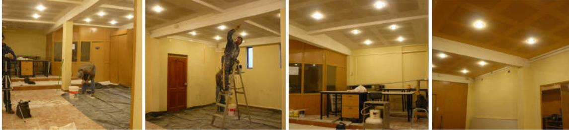
**Figura 32:** *Instalación focos empotrados y tratamiento de juntas y pinturas del cielo.*
