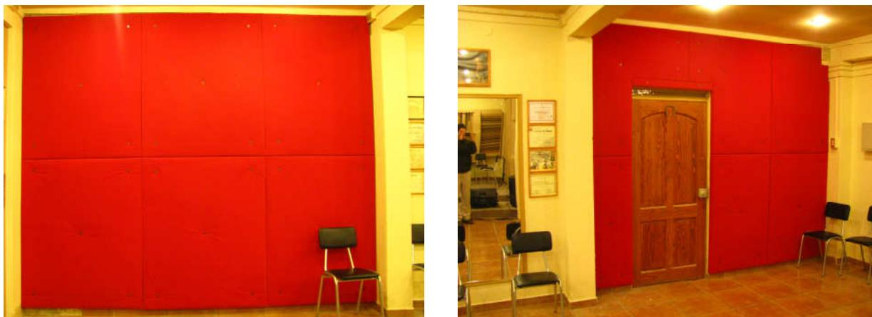
**Figura 40:** Absortores instalados en la pared 1.
