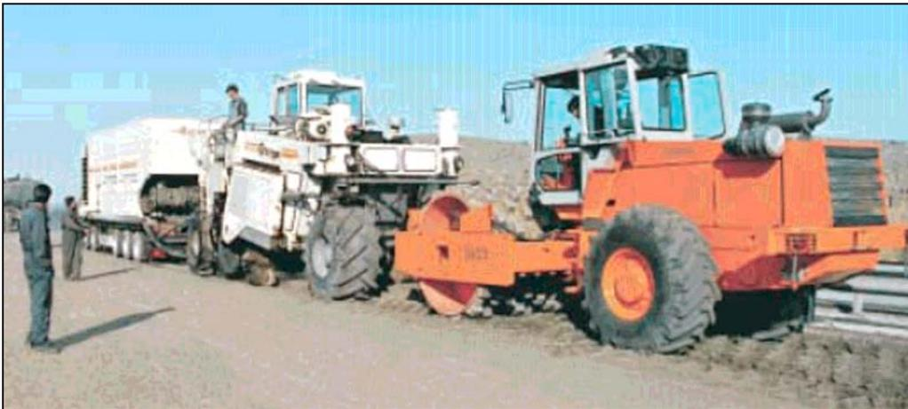
*Figura N°27, Reciclado en frío con asfalto espumado.*
