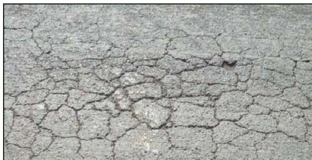
**Figura N°15, Pavimento flexible con notable figuración por fatiga.**
