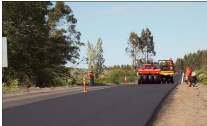
**Figura N°20, Uso de rodillo neumático 12 ton.**
