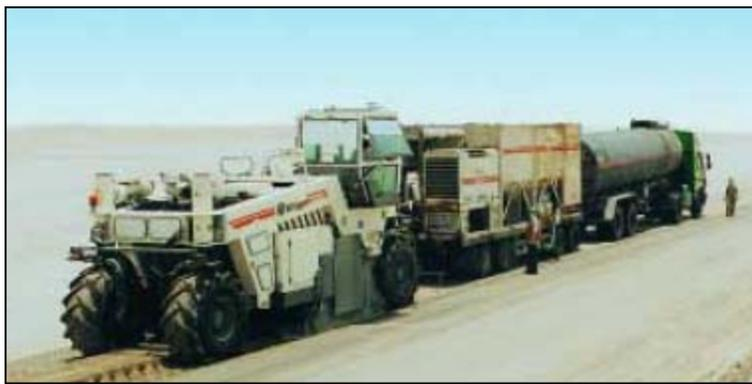
*Figura N°25, Tren de reciclado en funcionamiento.*
