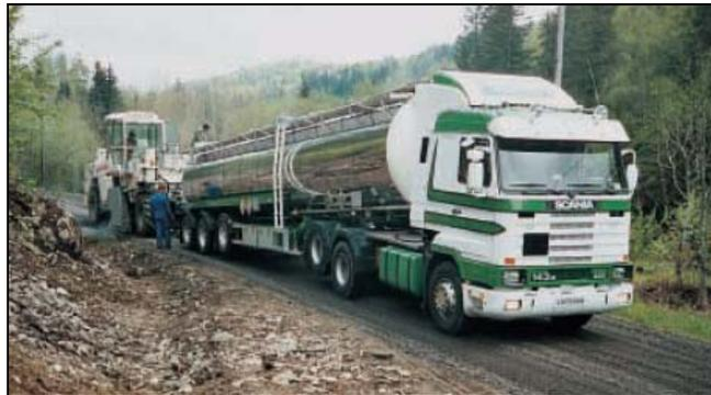
**Figura N°29, Recicladora con rendimiento de 2.500 m<sup>2</sup> en poco menos de 2 horas.**
