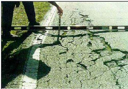
*Figura N°5, Ejemplo de ahuellamiento.*
