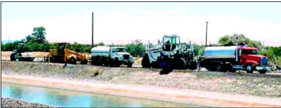
*Figura N°26, Tren reciclador de las vías.*
