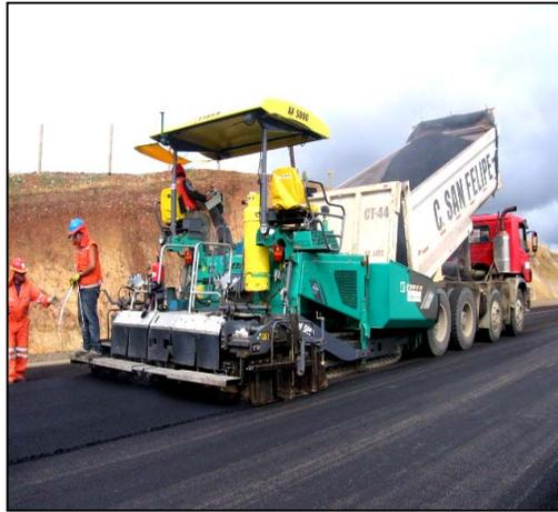
**Figura N°19, Aplicación de carpeta asfáltica.**
