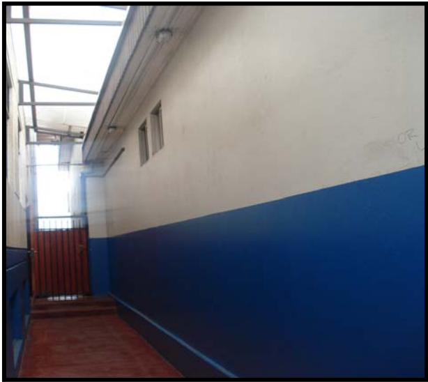
Figura 20: Muro noroeste albañilería de ladrillos confinada con estuco por ambos lados
