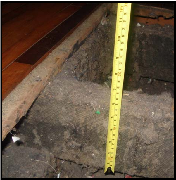
Figura 16: Viga maestra de roble en estructura de piso.
