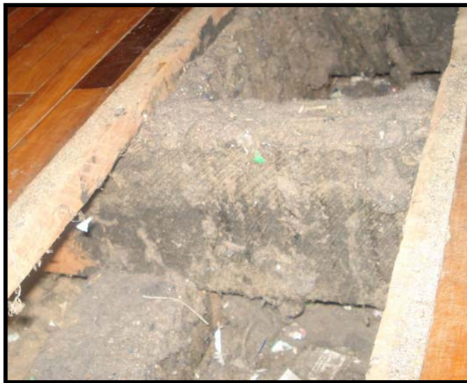
Figura 15: Piso compuesto de poyos de hormigón embebidos en el terreno compactado.
