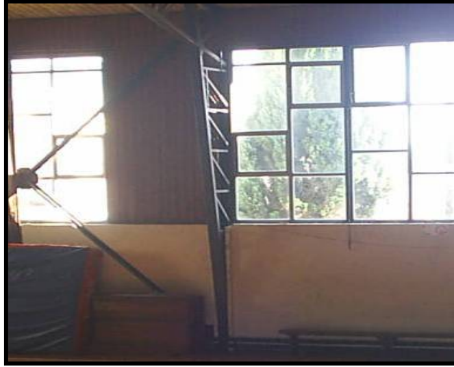
Figura 14: Ventanales con marcos de aluminio con vidrios simples y forro de tablas de pino
