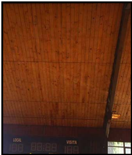
Figura 10: Techo de zinc y cielo de madera de pino.
