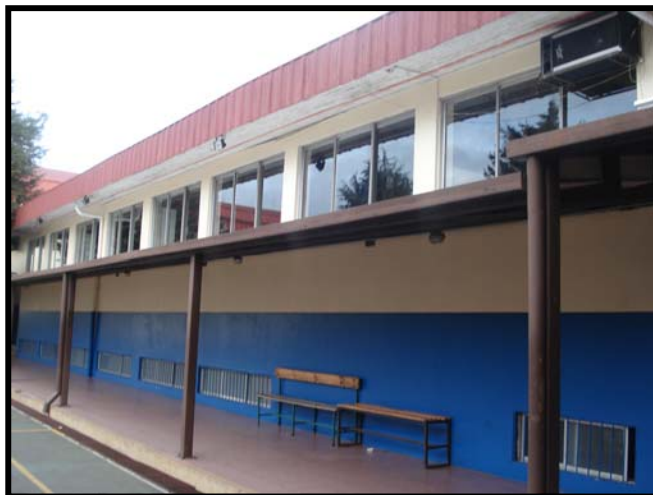
Figura 19: Muro noreste de albañilería de ladrillos confinada con estuco por ambos lados
