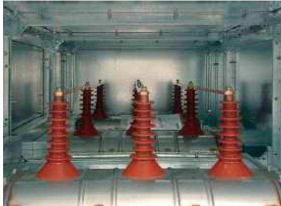
Los compartimientos poseen esta toma para tensión, las cuales son conductoras en las terminales que están sobre la superficie roja. El material dieléctrico usado para aislar, posee una rigidez dieléctrica de 30KV aprox.
