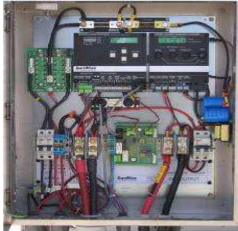
La Unidad de control y potencia del rectificador incorporada, posee sistemas de transmisión de datos RS 485, panel de control digital y pantalla LCD alimentación monofásica y tensión de salida  $-2 / + 2$  VDC.
