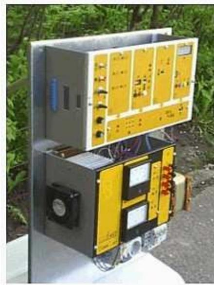
Unidad rectificadora con control analógico, alimentación trifásica, tensión de salida  $- 1.4/+ 1.4$  VDC y corriente de salida máxima 180 A. El sistema posee una eficiencia 75 % de aprovechamiento de la potencia de entrada.
