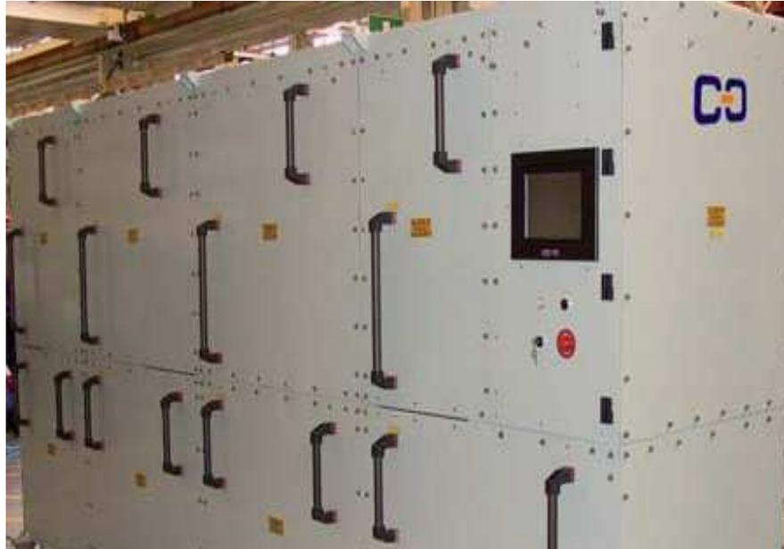
Esta figura N° 82, muestra un transformador reductor de tensión, el cual cuenta con un control de comando local vía una TOUCH-SCREEN (HMI), mediante es posible monitorear el estado de funcionamiento, alarmas, reset de alarmas y medida de perdidas internas, así como temperatura interna y núcleo del transformador eléctrico. Posee fuertes normas de seguridad, esta bajo resguardo hermético. Además posee la opción de añadir un ventilador eléctrico, para inyectar aire forzado, controlado vía el HMI.
