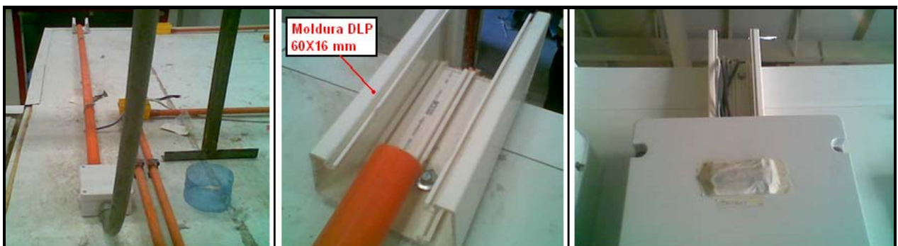
Figura N° 4.14 Fijación de moldura y unión con tablero.
