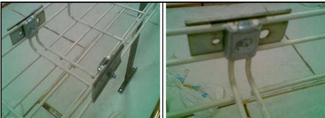
Figura N° 4.8 Unión de escalerilla con eclisa
