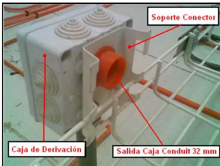
Figura N° 4.9 Montaje de caja de derivación a la escalerilla
