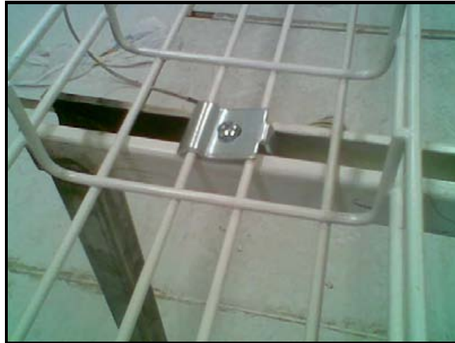
Figura N° 4.5 Fijación de mordaza a Riel RC
