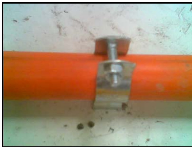
Figura N° 4.13 Fijación de tubo conduit con cubierta.
