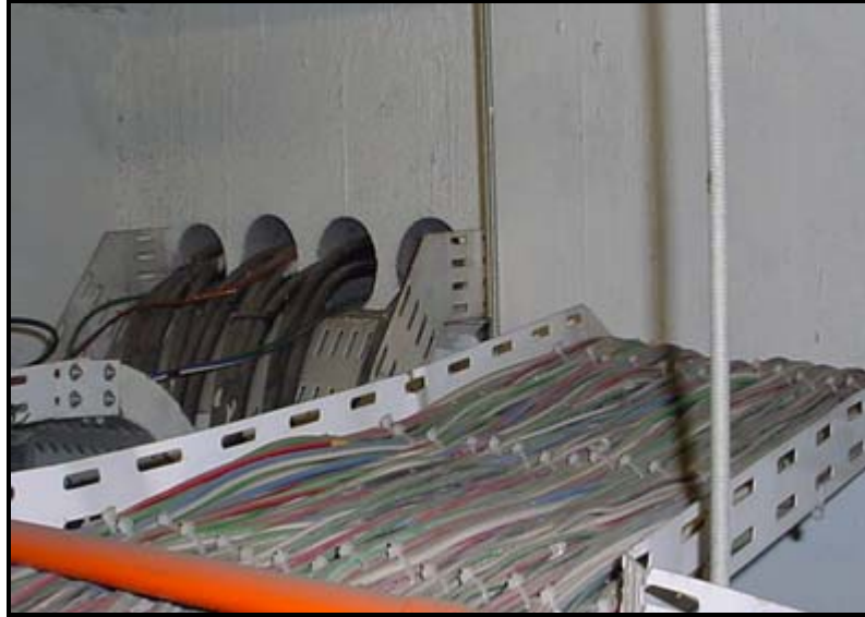
Figura N° 4.17 Disposición de conductores en escalerilla
