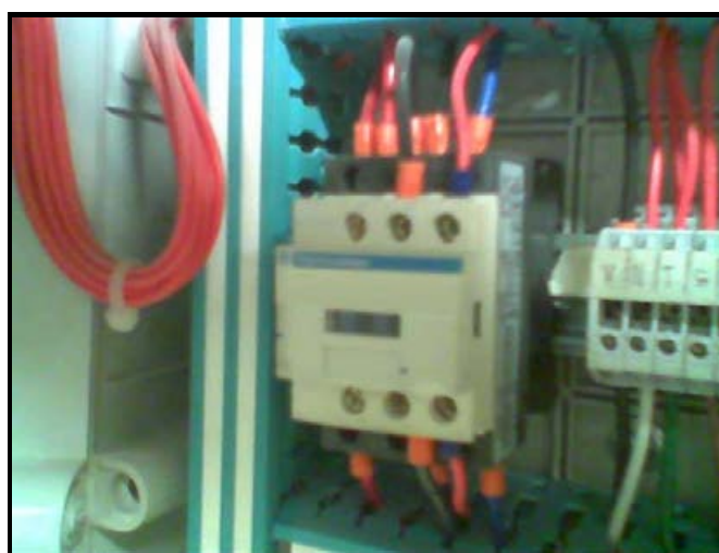
Figura N° 4.27 Contactor instalado.
