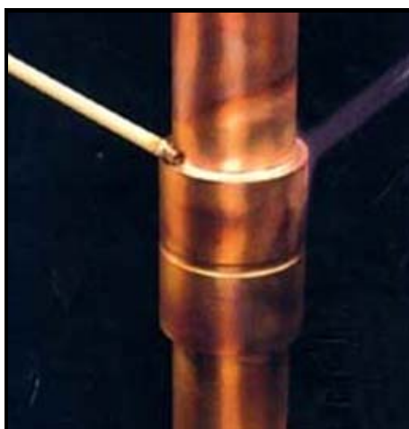
Figura Nº 3.51 Aplicación de soldadura
