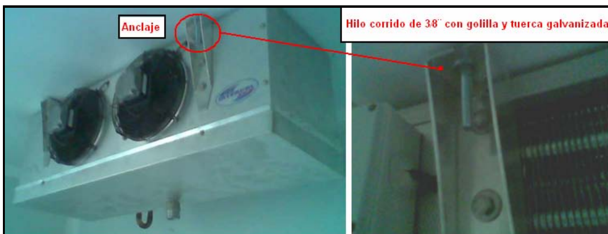
Figura N° 3.89 Anclaje del evaporador
