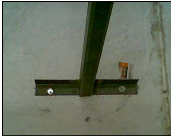
Figura N° 3.32 Anclaje al techo de la cámara.
