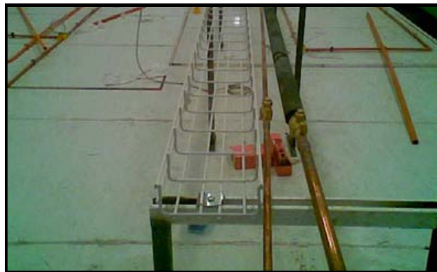
Figura N° 3.30 Soportación de las tuberías
