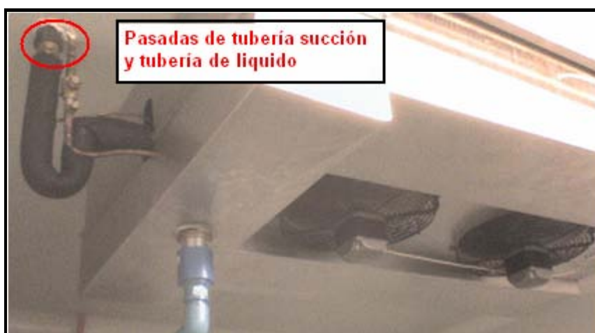
Figura N° 3.90 Pasadas de líneas hacia unidad condensadora
