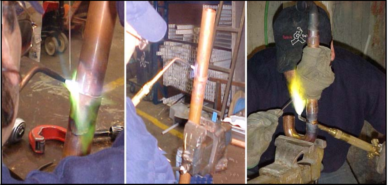
Figura N° 3.54 Soldadura en tuberías de cobre.
