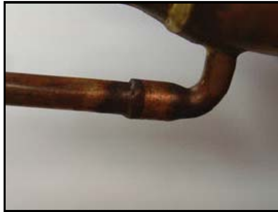
Figura N° 3.85 Unión de tuberías
