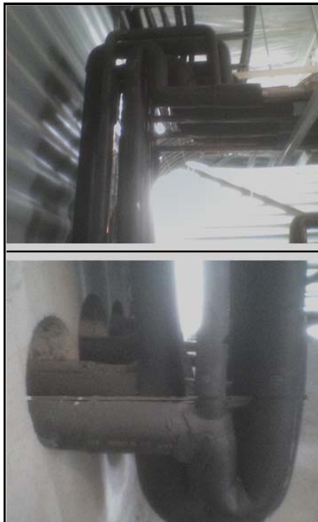
Figura N° 3.10 Fotografía subida doble con sifones
