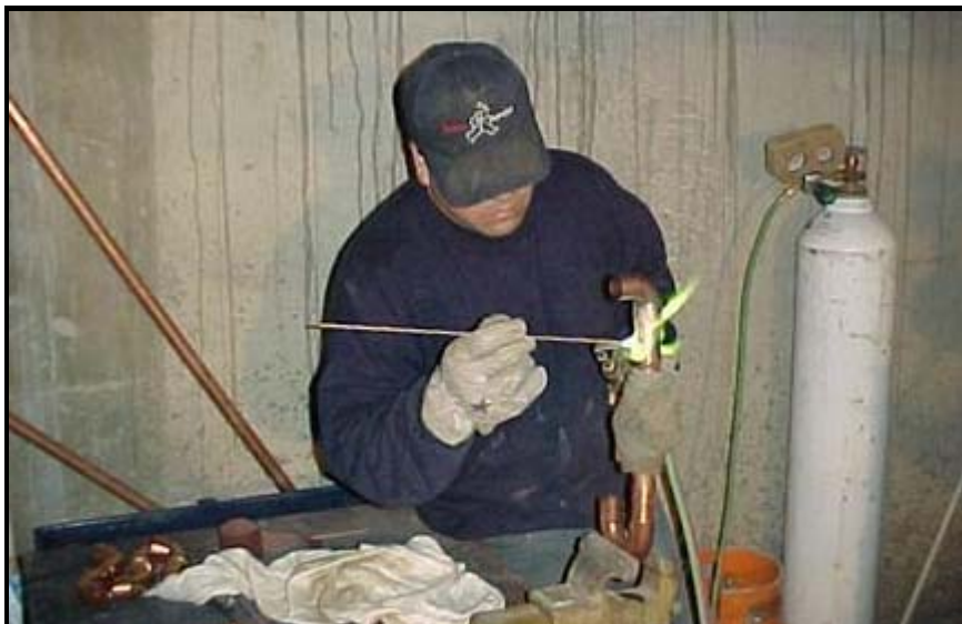
Figura N° 3.53 Soldadura en tuberías de cobre.
