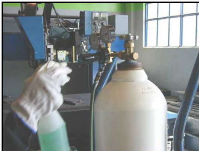
Figura N° 3.45 Detección de fugas
