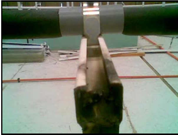
Figura N° 3.31 Instalación de abrazadera en riel RC
