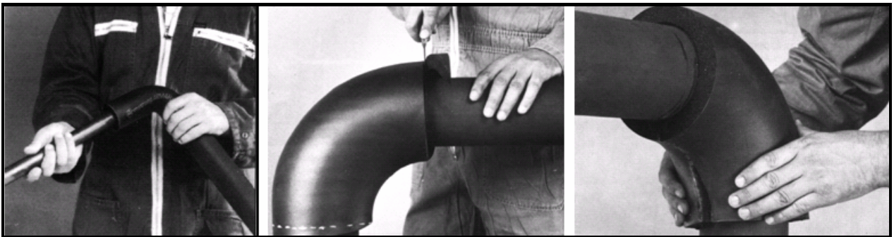
Figura N° 3.23 Ingreso de aislante en codo
