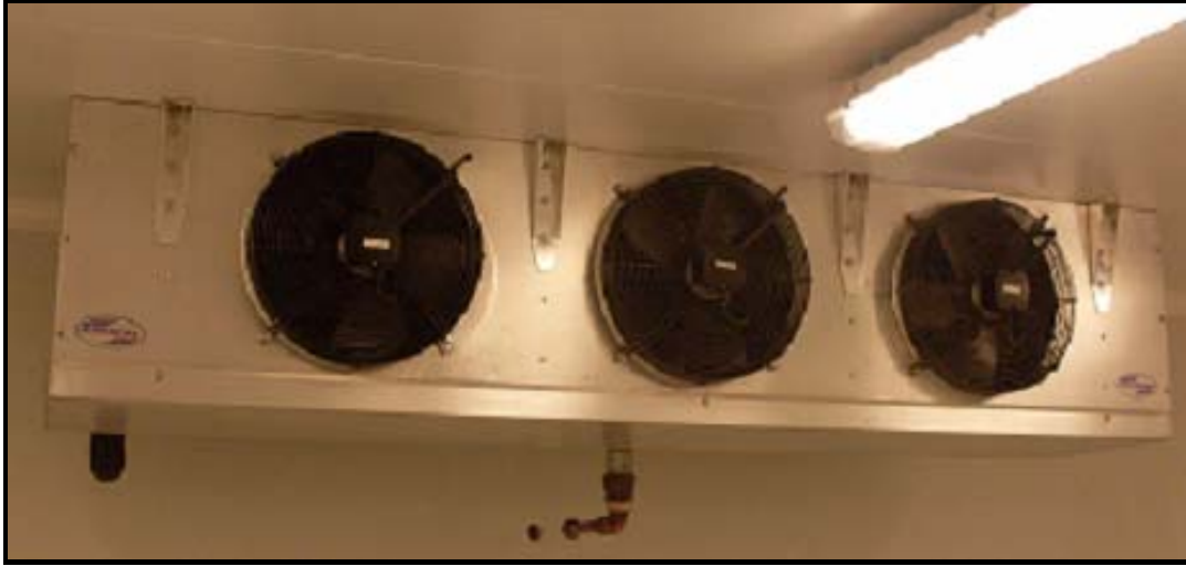
Figura N° 3.91 Montaje de evaporador
