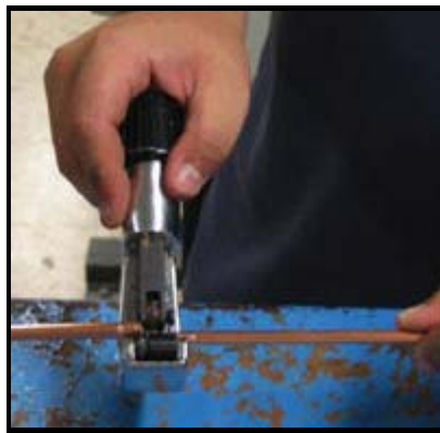
Figura N° 3.73 Corte de tubo
