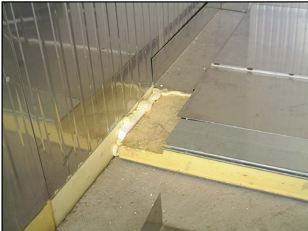
Figura N° 1.6 Fotografía obtenida en trabajos de obra durante montaje de cámara; Fuente: Empresa Aliserv.
