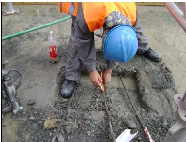
**Fotografía N°21 Marcación del estiramiento del cable una vez tensado.**
