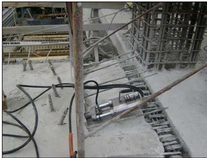
**Fotografía N°13 Tipo de equipo utilizado para tensar cables (gato hidráulico).**
