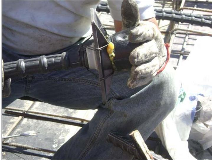
**Fotografía N°10** Cono, el cual está en forma temporal para dejar lugar a las cuñas luego de haber fraguado el hormigón, para así proceder con el tensado.
