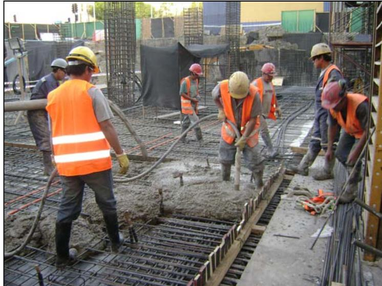
**Fotografía N°4 Equipo vibrador, utilizado durante el hormigonado de losa.**
