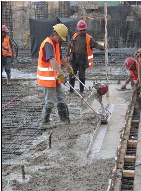
**Fotografía N°3 Regla vibradora.**
