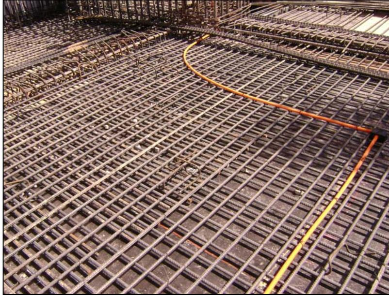
**Fotografía N°16 Caja eléctrica instalada sobre malla inferior de losa postensada (trabajo en paralelo de actividades de enfierradura y electricidad).**
