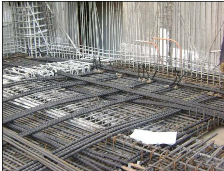
**Fotografía N°9 Cables con sistema de adherencia (despiches).**
