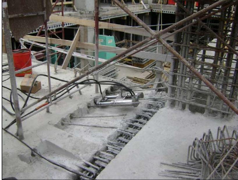
**Fotografía N°5 Gato hidráulico de tensado.**
