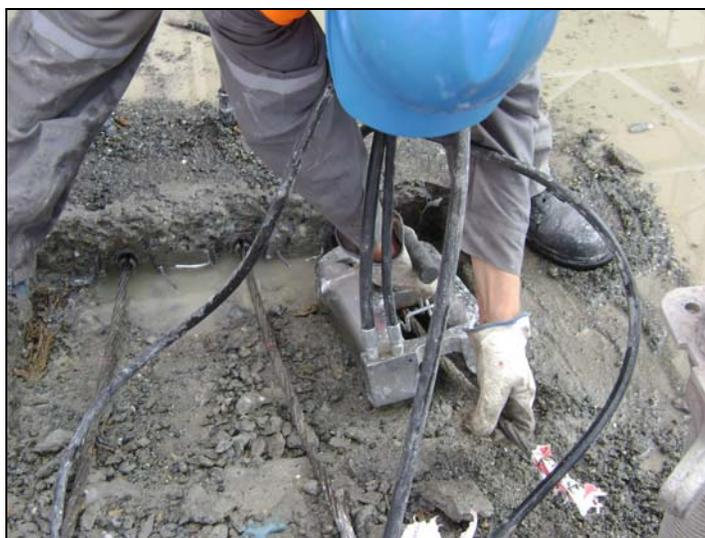
**Fotografía N°20 Preparación de equipo de tensado.**
