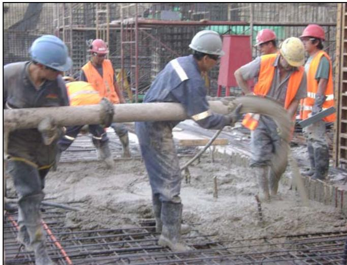
**Fotografía N°18 Proceso de hormigonado a través de bomba estacionaria, se observa uso de platacho y vibrado a medida que se está hormigonando.**
