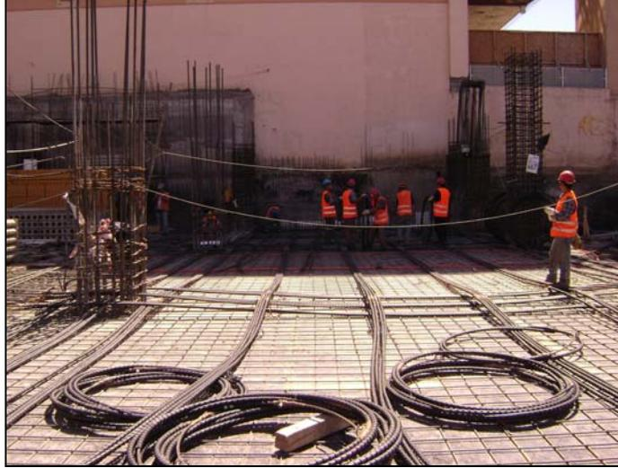
**Fotografía N°12 Ducto que se utiliza para sistema con adherencia.**
