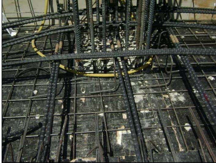
**Fotografía N°17 Refuerzo típico para soporte de cables.**
