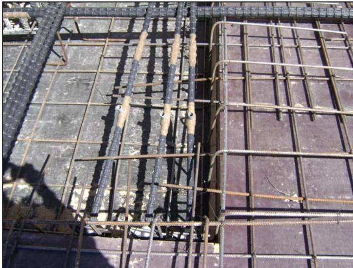
**Fotografía N°11** En este caso se utiliza como unión de tendones huincha de plástico, por falta de longitud del cable.
