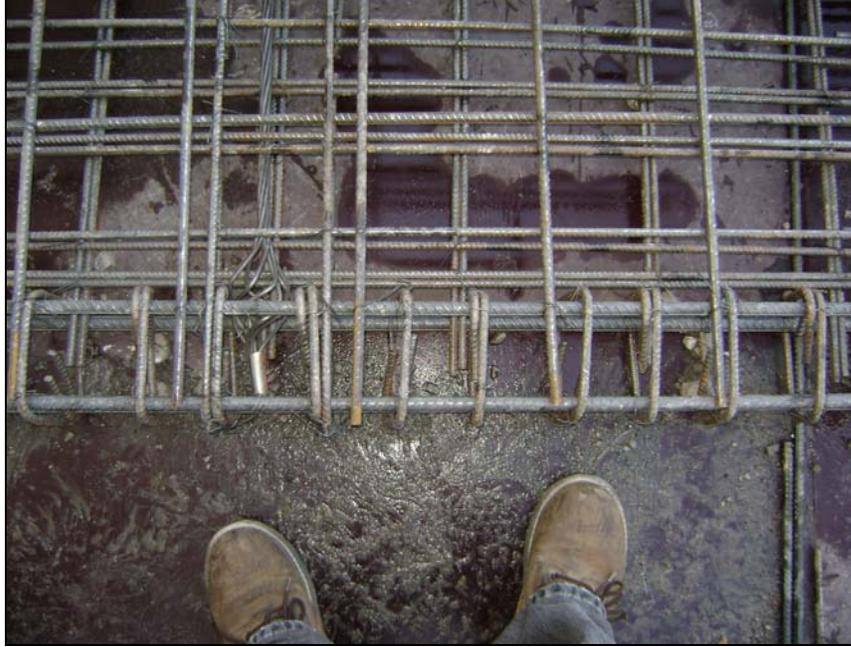
**Fotografía N°7 Anclaje pasivo (anclaje araña) en sistema con adherencia.**
