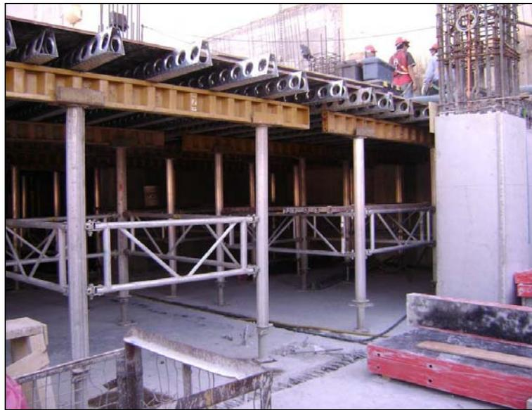
***Fotografía N°15 Alzaprimado metálico.***
