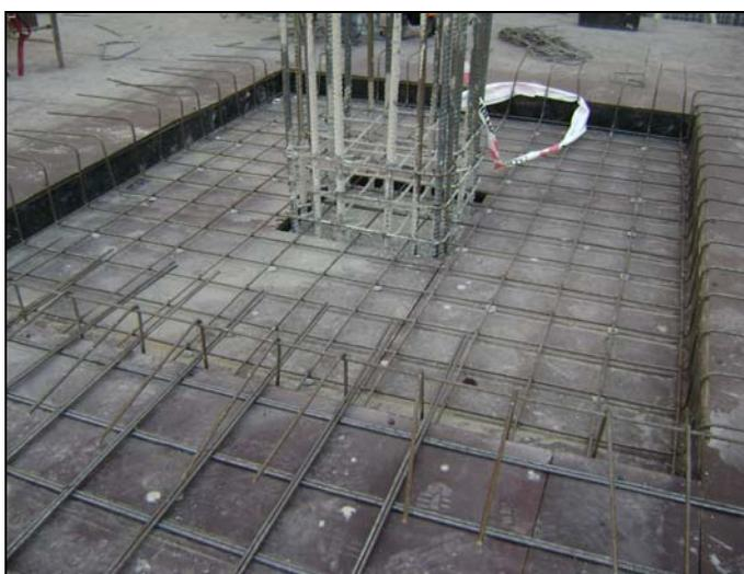
**Fotografía N°14 Placas fenólicas utilizadas como Moldajes para losa y capitel.**
