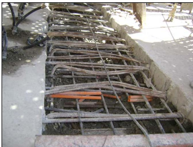
**Fotografía N°2 Juntas de dilatación en uniones de coladas.**
