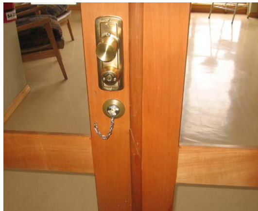
Figura N°35, Puerta posterior 3° piso.
