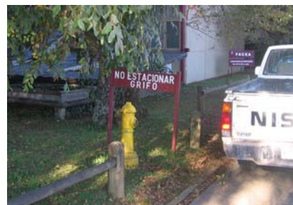
Figura N°42, Grifo ubicado cerca de las instalaciones de ecología y evolución.
