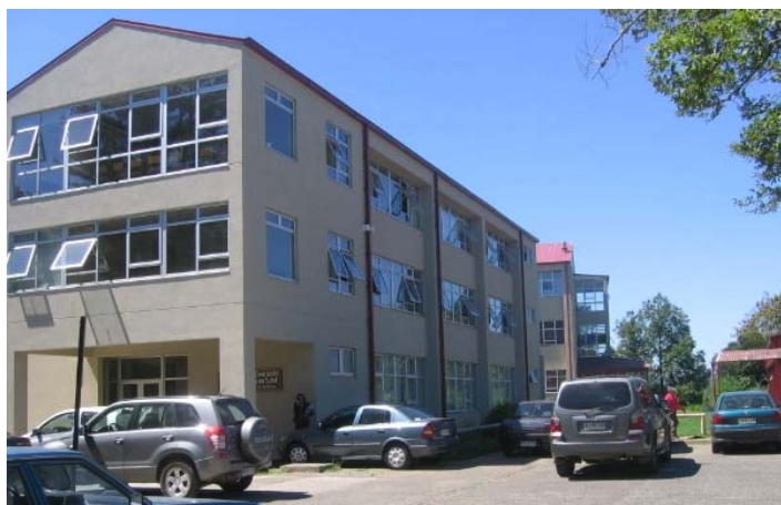
Figura N°33, Fachada lateral, edificio Ciencias del Cuidado en Salud.
