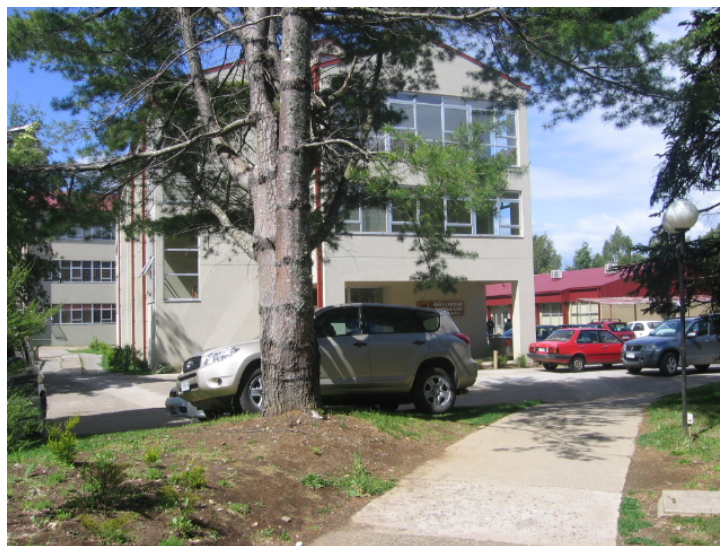
Figura N°31, Fachada principal, edificio Ciencias del Cuidado en Salud, antes de la colocación de los postes de madera.
