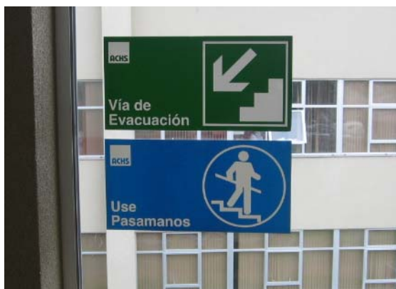
Figura N°25, Señales de seguridad instaladas en las escaleras.
