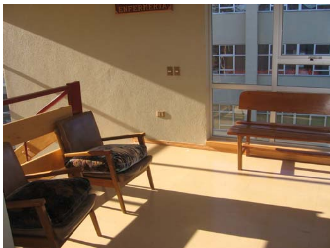
Figura N°29, Acceso escalera 2° piso lado posterior edificio Ciencias del Cuidado en Salud.
