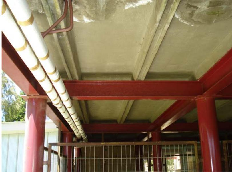
**FIGURA N° 19** Piso ventilado Casino Miraflores.
