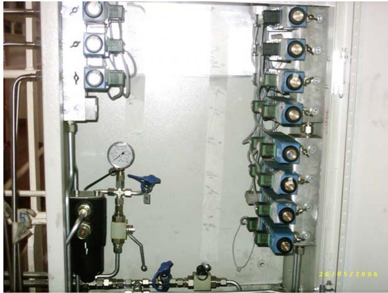
Figura 4.15: Tablero de válvulas solenoides controladas en forma remota.
