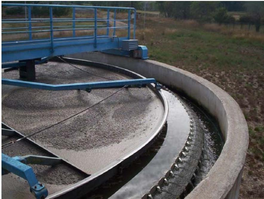
Figura N°7. Flotador de Lodos.
