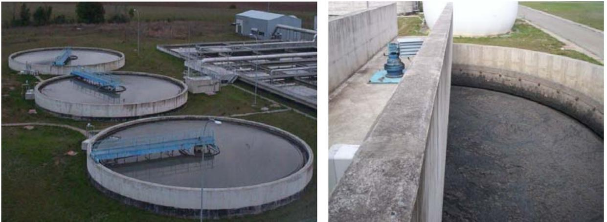
Figura N°4. Decantación Primaria (Izquierda) – Espesador de Lodos (Derecha).
