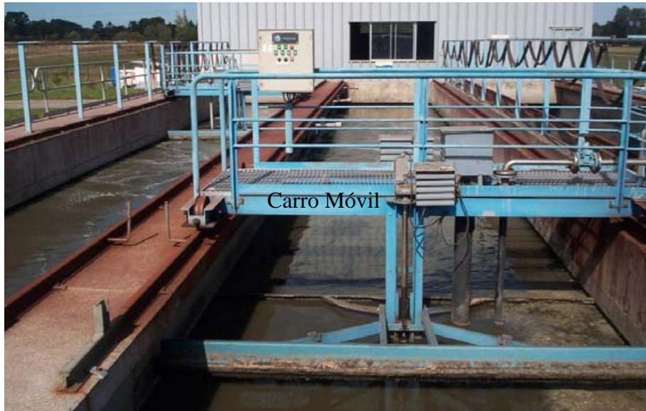
Figura N°3. Puente desarenador en funcionamiento.
