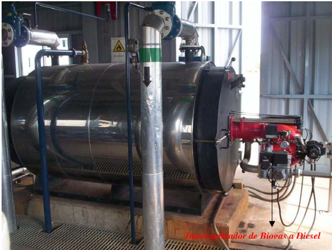
Figura N°8. Caldera Acuatubular Operada con Biogás o Diesel
