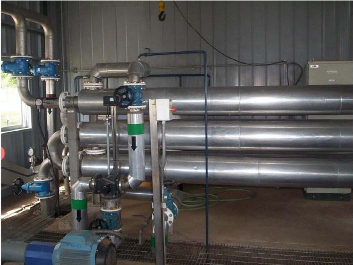
Figura N°9. Intercambiador de Calor de 6 Tubos Concéntricos.
