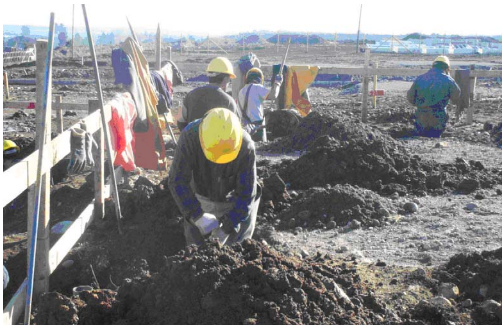
Figura N 5.4: Cuadrillas Ejecutando la Excavación. Imagen extraída de empresa constructora.
