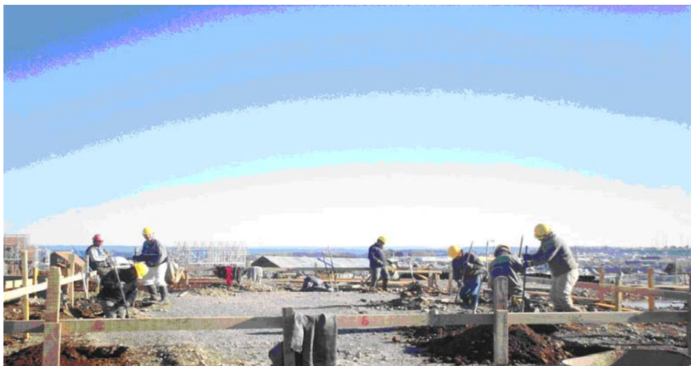
Figura N 5.3: Comienzo Partida de Excavación. Imagen extraída de empresa constructora
