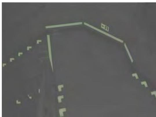
Foto N°29, Balizamiento fotoluminiscente en vías verticales de evacuación
