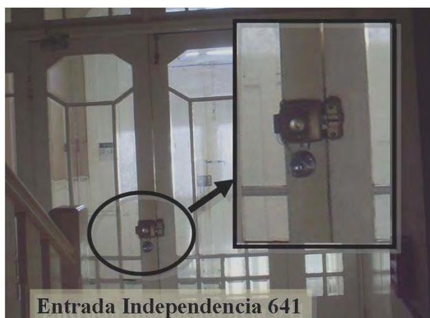
Imagen N°15, Vía de evacuación cerrada por sistema eléctrico
