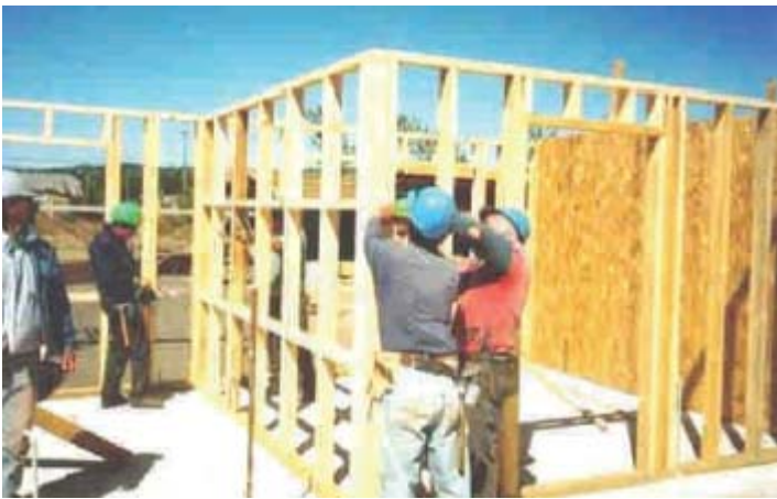
Figura 4 - 28: El elemento finalmente es levantado, anclado y fijado sobre su eje de ubicación de forma rápida y expedita
