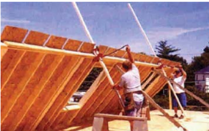
Figura 4 – 26: Etapa de montaje de muros prefabricados en obra directamente sobre la plataforma
