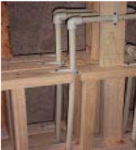
Figura 1 - 3: El panel llega a la obra con instalaciones, recubrimientos y terminaciones.
