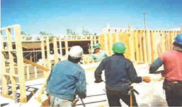
Figura 4 - 27: Traslado manual del elemento prefabricado en obra, de dimensiones 3,20 m de ancho por 2,40 m de alto
