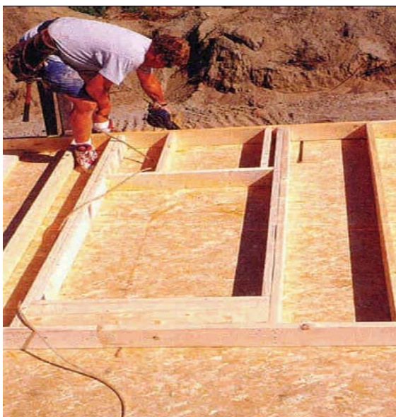
Figura 3 - 1: La calidad de la madera utilizada es esencial para la prefabricación de los entramados verticales, ya que de ello depende fundamentalmente la durabilidad y estabilidad de los elementos en servicio.
