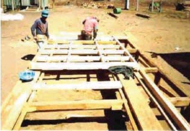
Figura 4 – 10: Ejemplo de prefabricación de un tabique divisorio en mesa de armado en obra.
