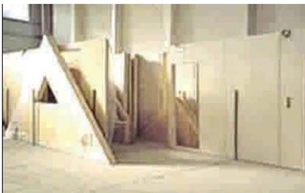
Figura 1 - 4: Estructuras preparadas (tabiques, frontones) para ser trasladadas al lugar donde se está construyendo.
