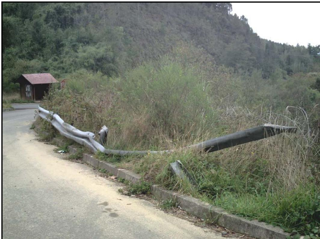
**Figura 19.c. Terminal Completamente Inutilizable.**
