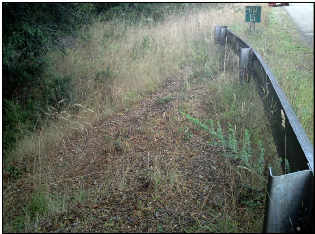
**Figura 18.b. Talud de Terraplén Cubierto de Abundante Maleza.**
