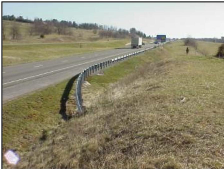
**Figura 4. Barrera con terminal enterrado en un talud de corte.**
