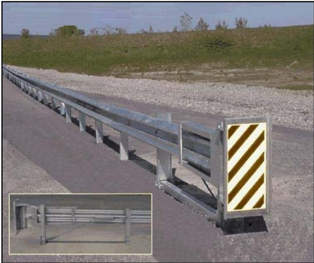
**Figura 5. Terminal atenuador del tipo extrusor.**
