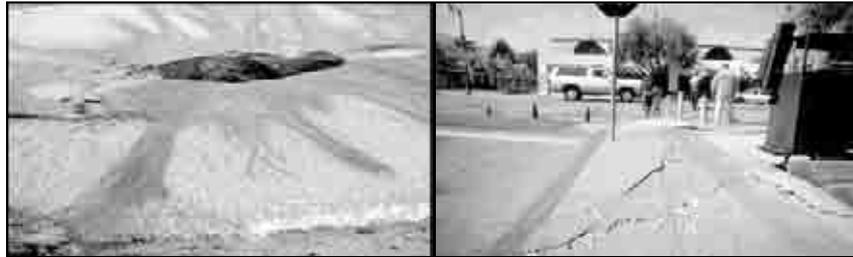
**Figura 2.2.5b** Efecto sobre el material granular que fluye hacia la superficie; efecto de amplificación del suelo. Terremoto de Loma Prieta, área de la bahía, San Francisco *US Geological Survey*.
