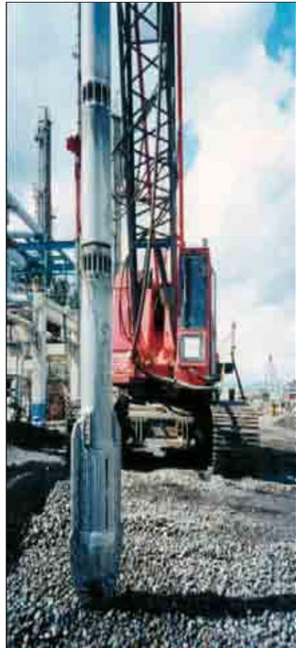
**Figura 4.2.3.1** Vibrador metálico suspendido de grúa
