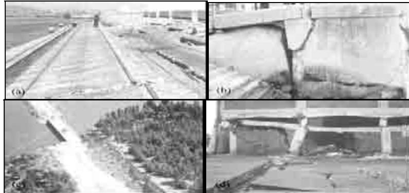
**Figura 2.2.5d** Daños producidos por fallas de suelos en Valparaíso y San Antonio en el terremoto de 1985, (a) Vista desde sitio 1 hacia San Antonio, (b) falla de estructura de contención y hundimiento de rellenos en muelle Prat, (c) falla de talud y terraplén de acceso a puente, (d) hundimiento de fundaciones por licuefacción (Troncoso, 1992).
