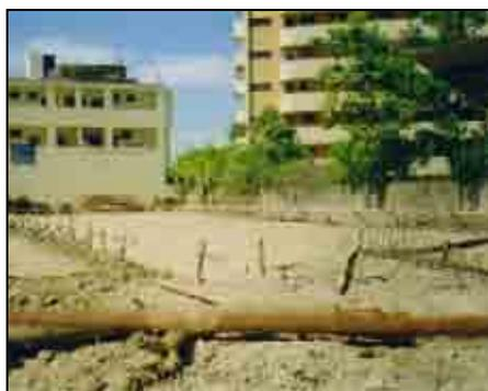
**Figura 4.4.1f** Terreno preparado para construir la placa de fundación.
