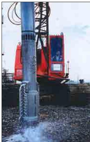
Vibrador Bauer modelo TR 13 utilizado en el mejoramiento
