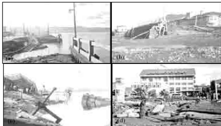
**Figura 2.2.5e** Daños producidos por fallas de suelos en Puerto Montt en el terremoto de 1960, (a) y (b) licuefacción de suelos de relleno en la costanera, (c) deslizamiento del terreno en el puerto, (d) hundimiento de una estatua por pérdida de la capacidad de soporte (Fotos de Kurt Grassau).
