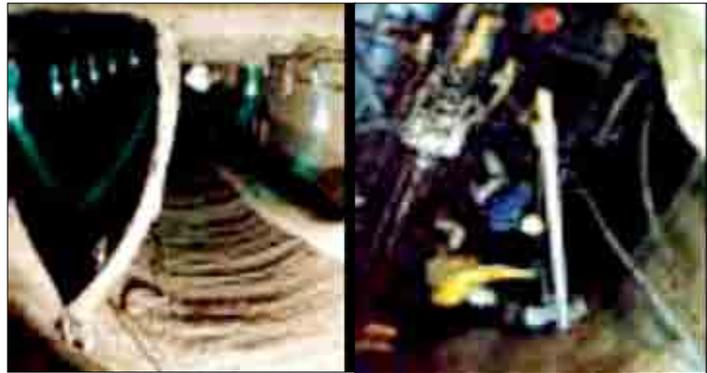
**Figura 4.5.3.3d** Excavación por secciones e instalación de tubos Manguitos para minimizar asientos en la construcción de un túnel.
