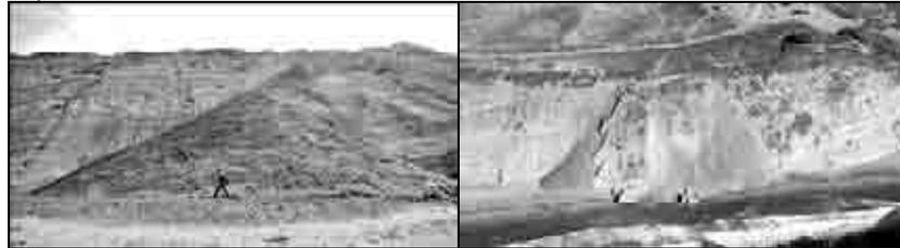
**Figura 2.2.5c** Efectos de deslizamiento debido al terremoto de Loma Prieta. *US Geological Survey*.
