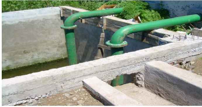
FIGURA N° 7 Succión de la bomba.
