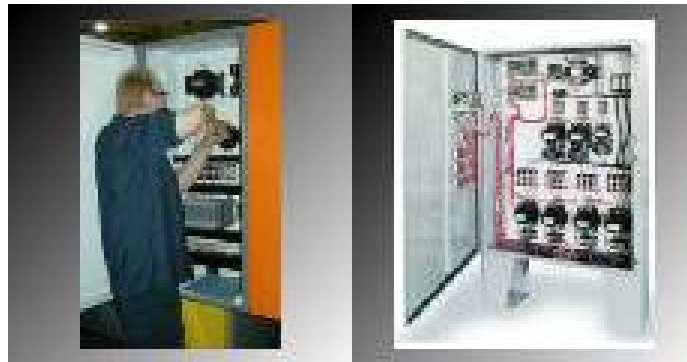
FIGURA N° 37 Mantenición de tablero eléctrico.
