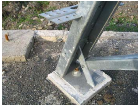
FIGURA N° 18 Perno de anclaje
