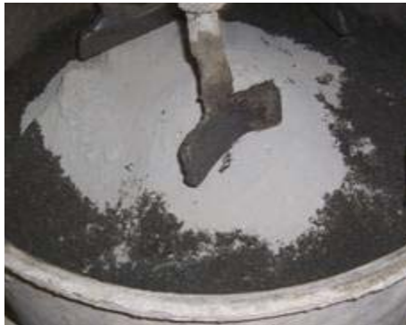
Fotografía N° 2: Betonera con arena y cemento.
